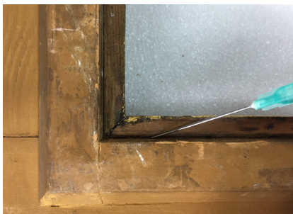
Fig. 65 Inyección del adhesivo
