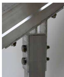
Detalle unión pata-viga
