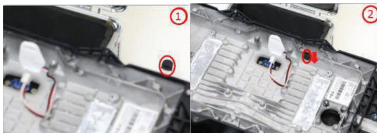
Figuras (6.10): Instalación de una goma impermeable
