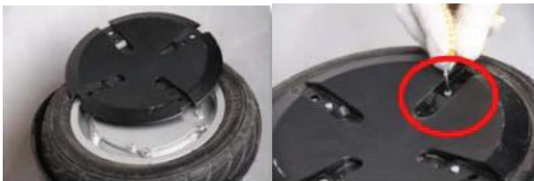
Figuras (6.11): Instalación de la cubierta decorativa
