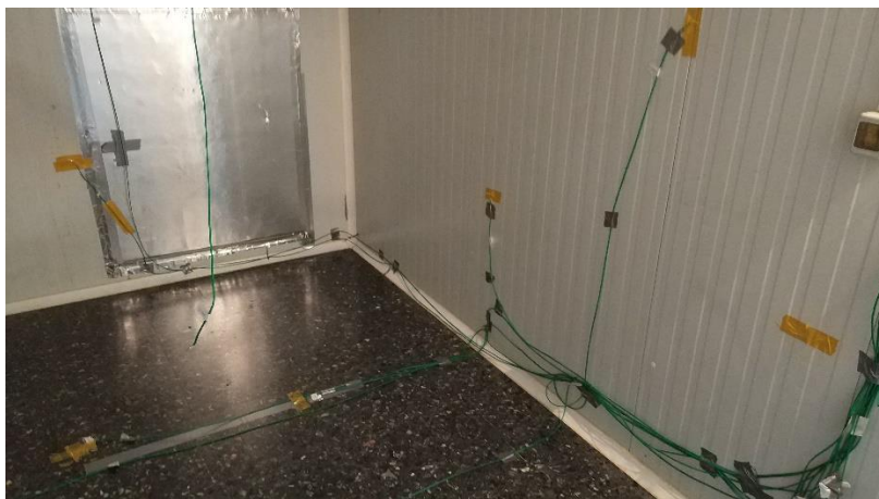
Ilustración 7: Instalación de los termopares en el interior de la cámara.
