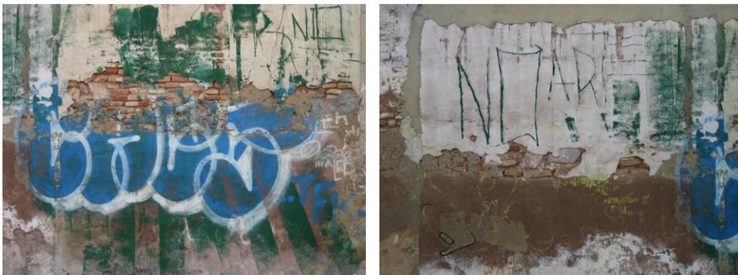
Arriba : debido al mal estado de los muros por el tiempo, la mala calidad de la argamasa, el exceso de arena, etc., las pintadas se encuentran en muy mal estado de conservación.
