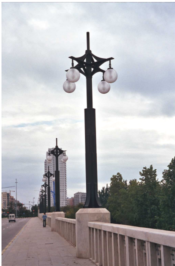
F405. Tramo XI farola del Puente del Reino
