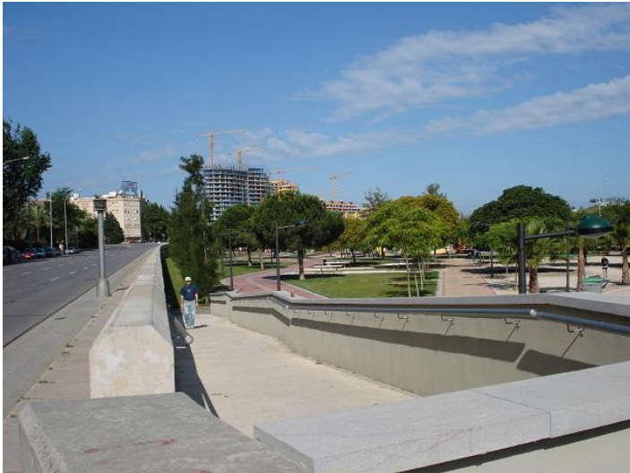
F7. Tramo I Rampa de acceso A
