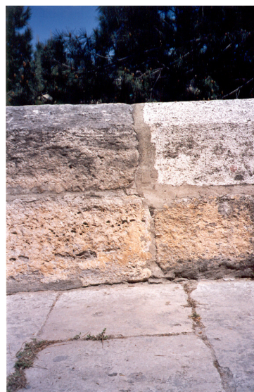
F417. Tramo II Petril correspondiente a Puente de Campanar
