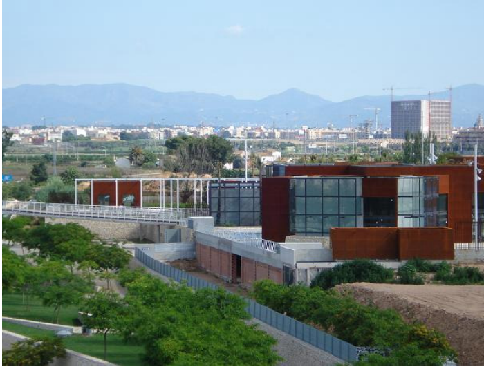
F363. Tramo I edificios de oficinas del Bioparc
