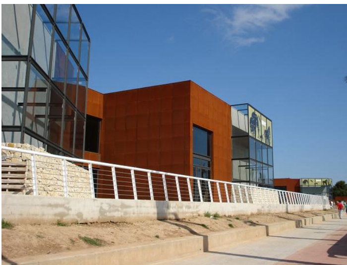
F359. Tramo I edificios de acogida Bioparc D
