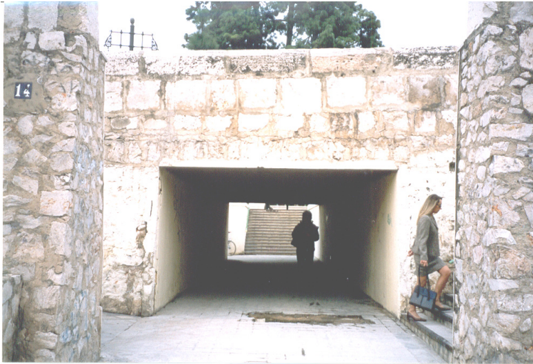
F311. Tramo VIII acceso subterráneo desde el Puente del Real a Viveros o Jardines del Real
