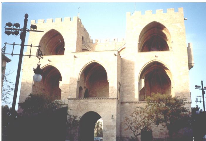
F173. Tramo V Parte Posterior de Torres de Serranos
