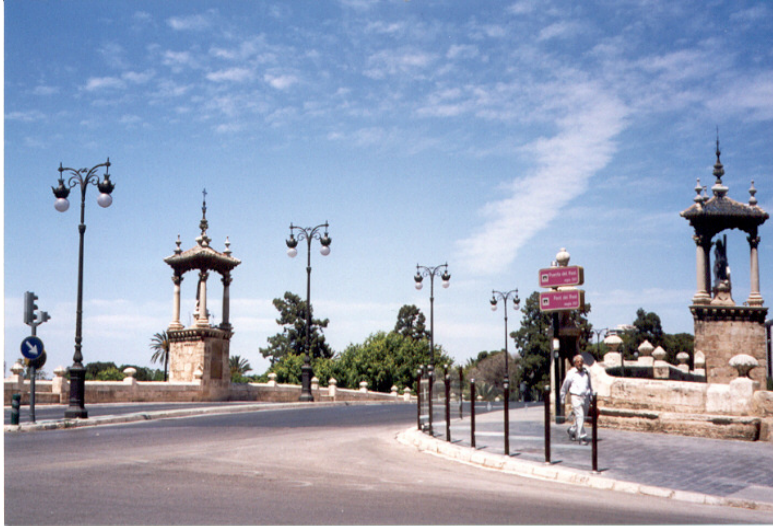
F197. Tramo VII Puente del Real
