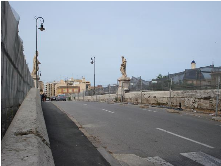
F189. Tramo VII Puente de la Trinidad, superior. En restauración
