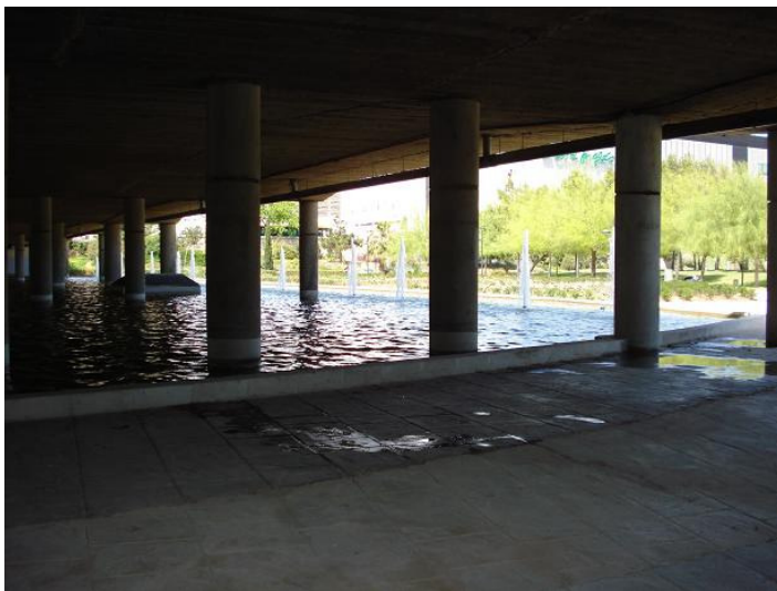
F381. Tramo II Parte inferior del Puente de Ademuz
