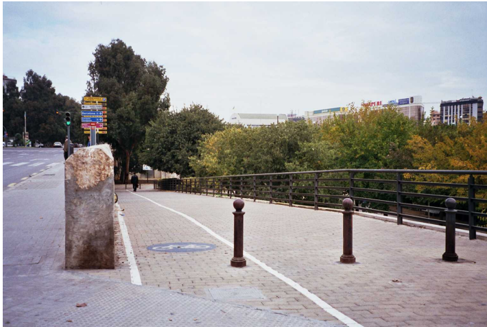
F82 Tramo XI bajada Puente del Reino
