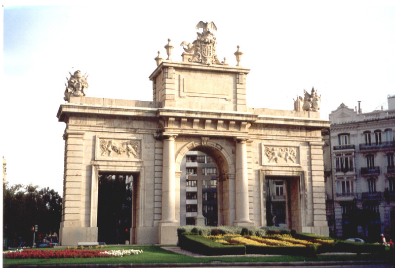
F208 Tramo VII Puerta del Mar
