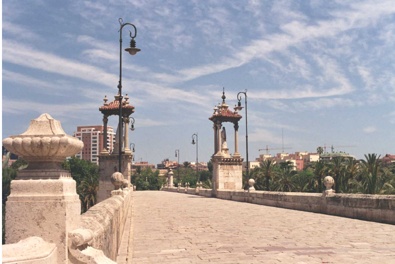
F213. Tramo IX Puente del Mar
