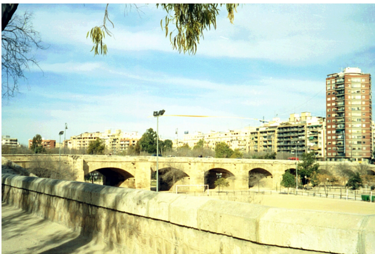
Imagen 4, Puente de Serranos ingeniería en su época.
