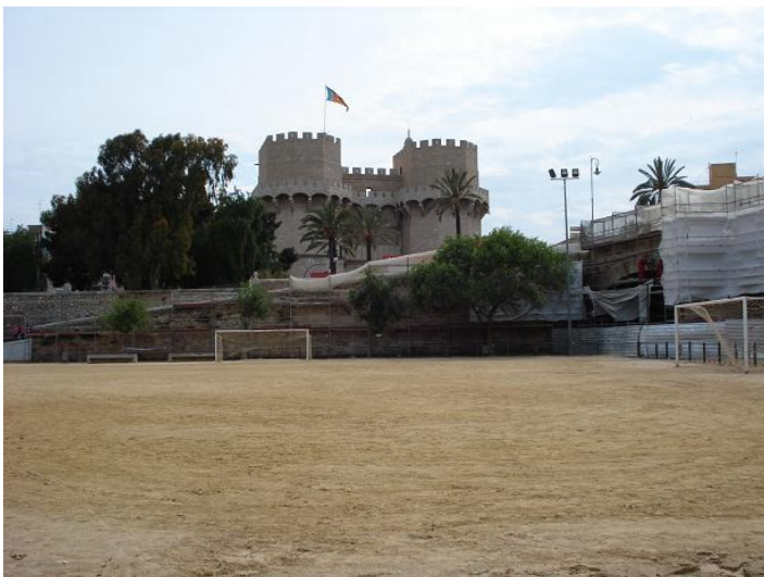
F171. Tramo V Puente de Serranos en restauración lado y vista de las Torres
