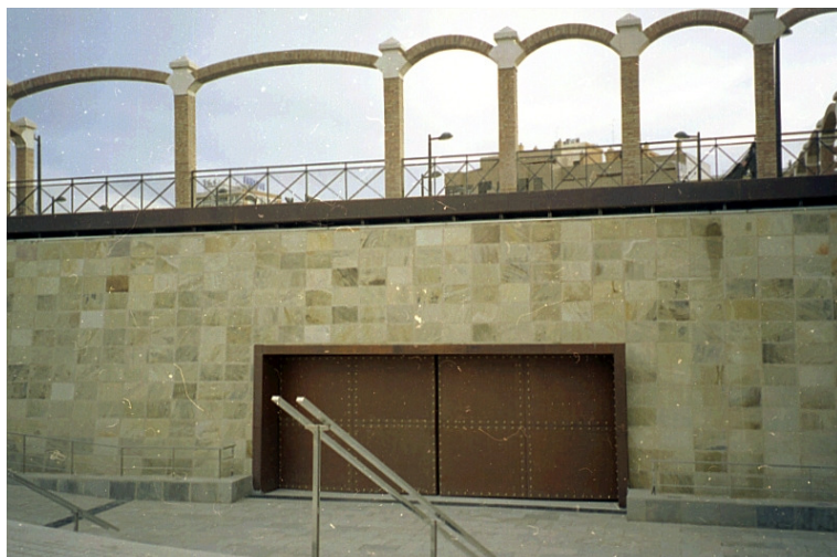
F90. Tramo I exterior MHC
