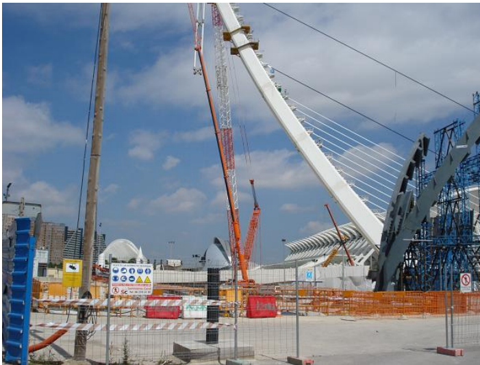
F413 Tramo XI Detalle parte inferior de la construcción del Puente de Serrera
