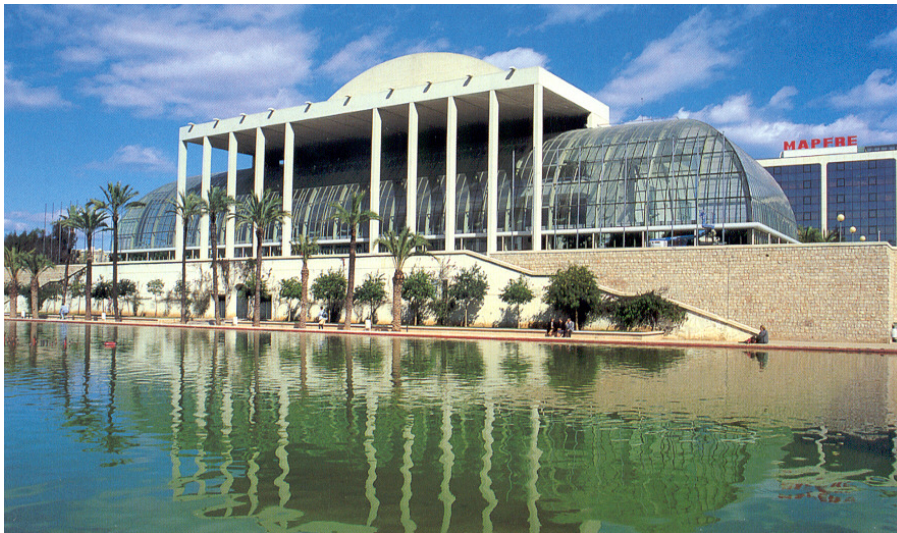
F264 Tramo X Fachada principal del Palau de la Música
