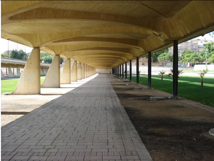
F373. Tramo I Parte inferior del Puente Nueve de Octubre
