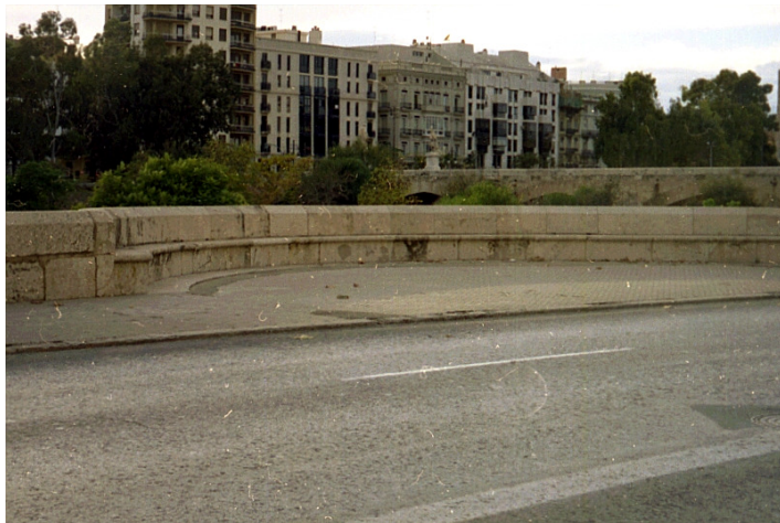
F420. Tramo IV Petril correspondiente a Puente de San José, entrante semicircular con banco
