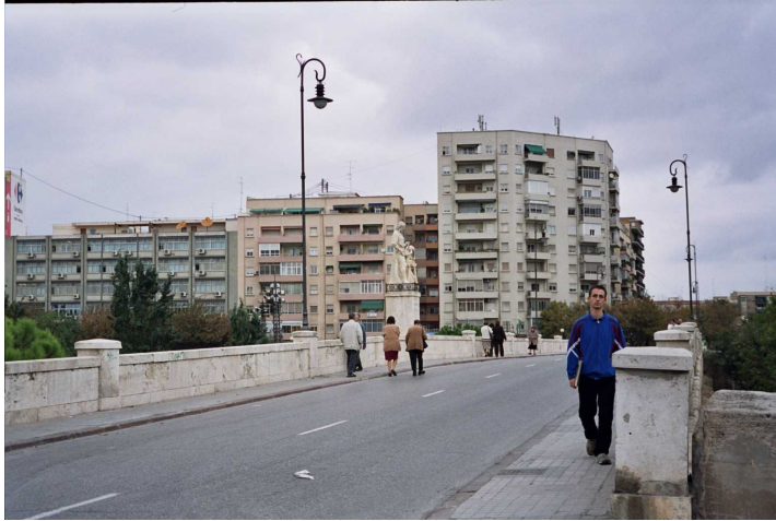
F133 Tramo V Puente San José, superior
