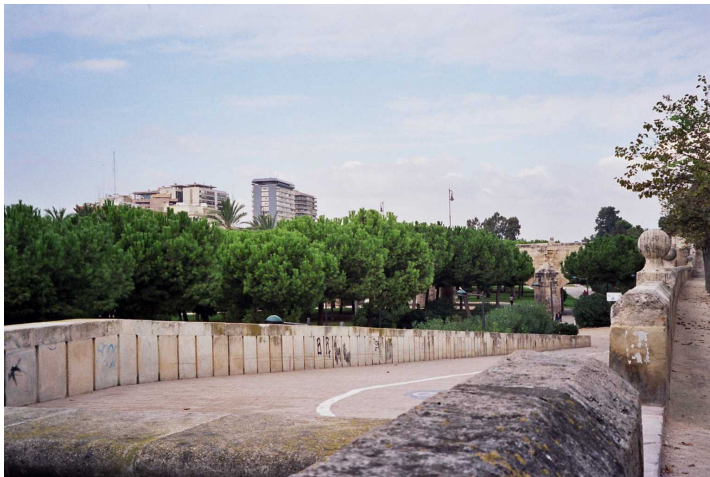
F65. Tramo VIII bajada del puente del Mar
