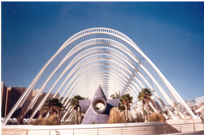
F245. Tramo XI interior Umbracle B
