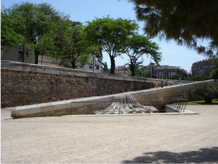
F33. Tramo III Rampa de acceso al Botánico
