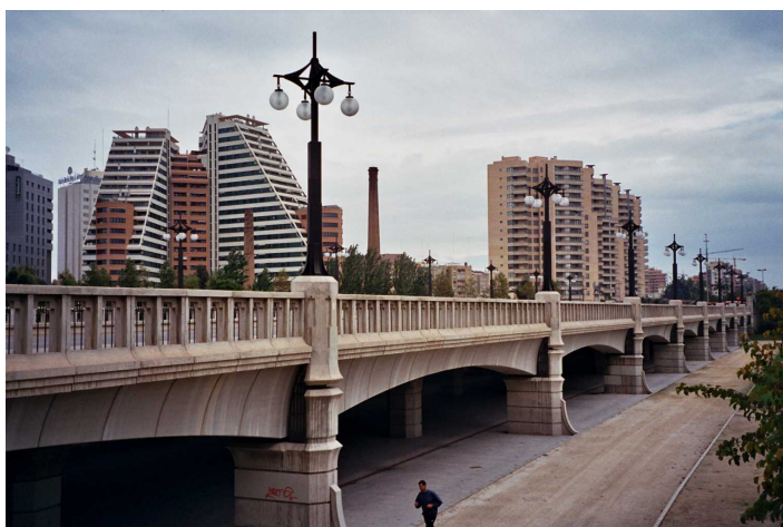
F407. Tramo XI Puente de Ángel Custodio
