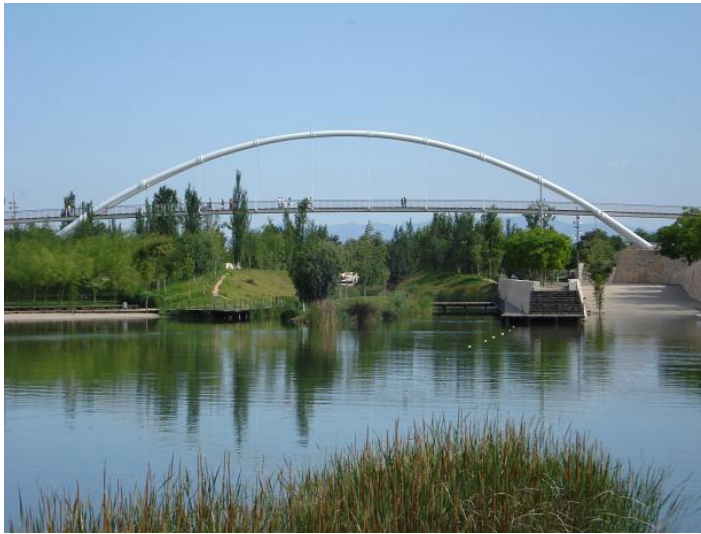
F339 Tramo I Puente sobre el lago del Parque de Cabecera
