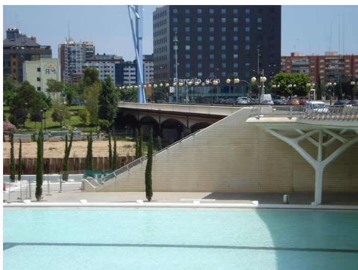
F411 Tramo XI unión entre al primigenio y la ampliación del Puente de Monteolivete
