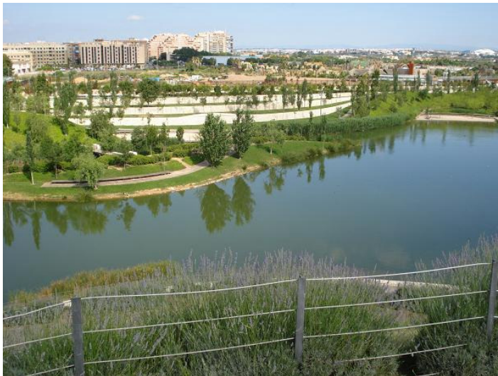
F343. Tramo I Vista general del Bioparc desde el Parque de Cabecera
