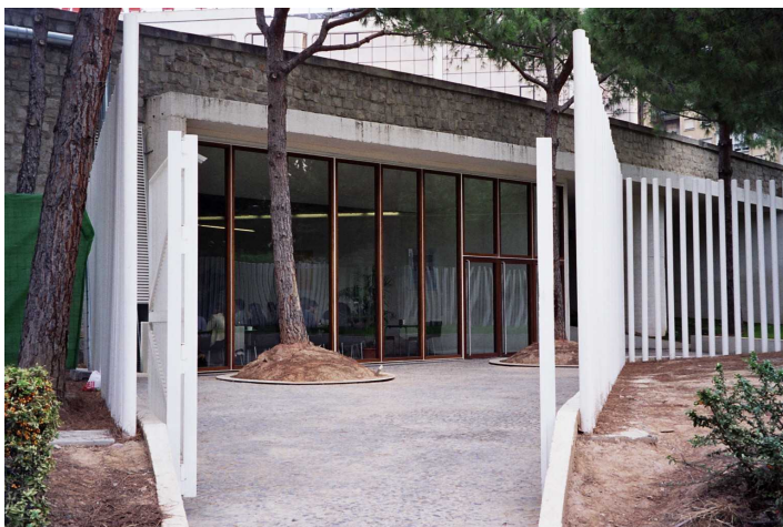
F267. Tramo X ampliación Cafetería del Palau de la Música
