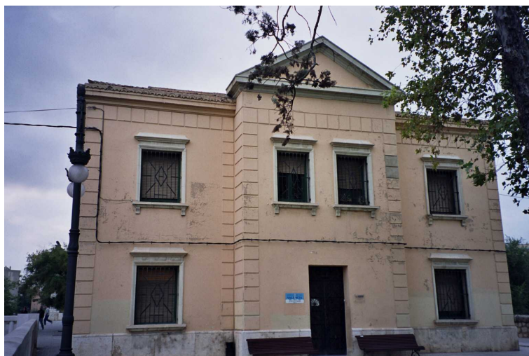
F140 Tramo V inicio de las Alameditas de Serranos. Centro de asistencia social
