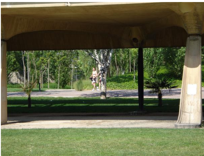
F374. Tramo I Parte inferior del Puente Nueve de Octubre, detalle
