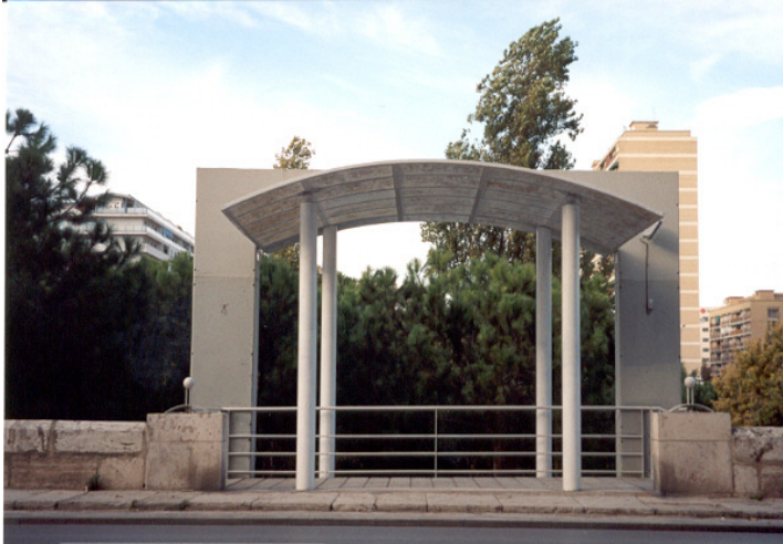
F13. Tramo I escalera de acceso
