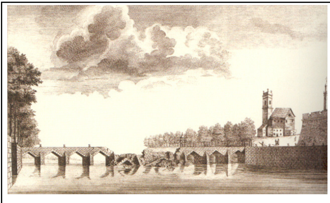
Fig. 15, Vista del Puente del Real tras la riada
