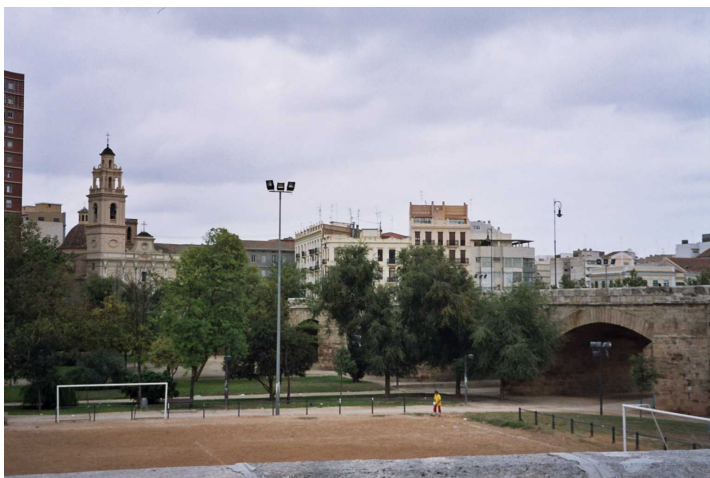
F50 Tramo IV Zona deportiva bajo puente se Serranos
