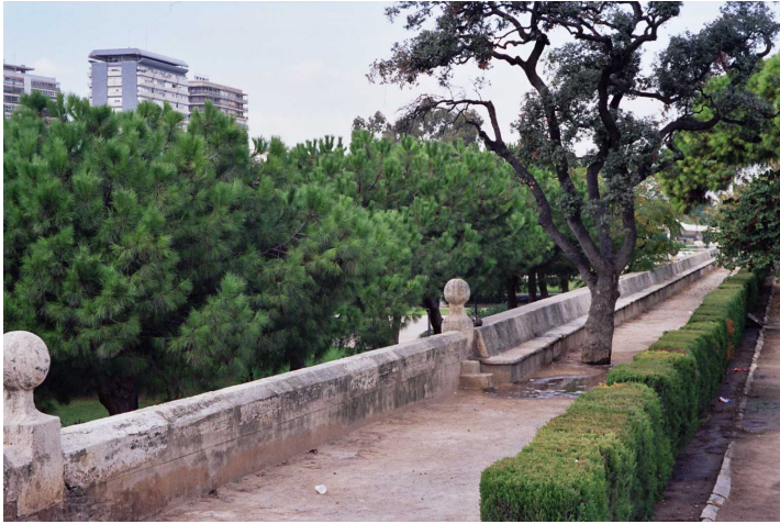
F67. Tramo IX parte superior correspondiente a la Alameda
