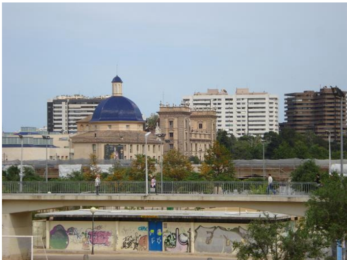
F57. Tramo VI Pasarela y vista de San Pío V
