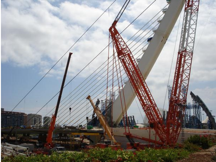
F412 Tramo XI Construcción Puente de Serrera
