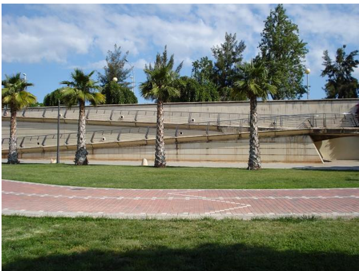
F375. Tramo I Parte inferior del Puente Nueve de Octubre, Acceso
