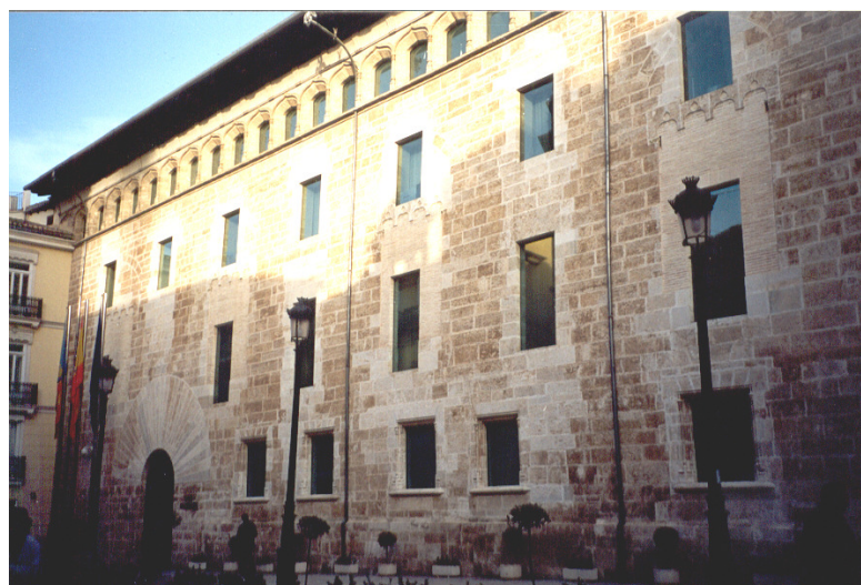
F176 Tramo VI Fachada Palacio de Benicarló
