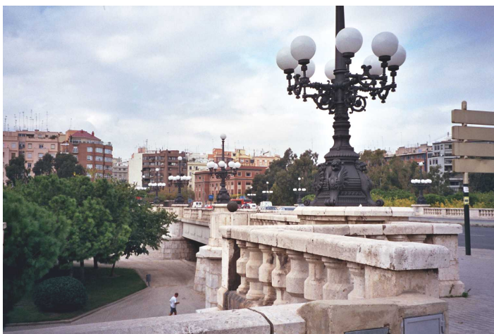
F402 Tramo XI Puente del Reino
