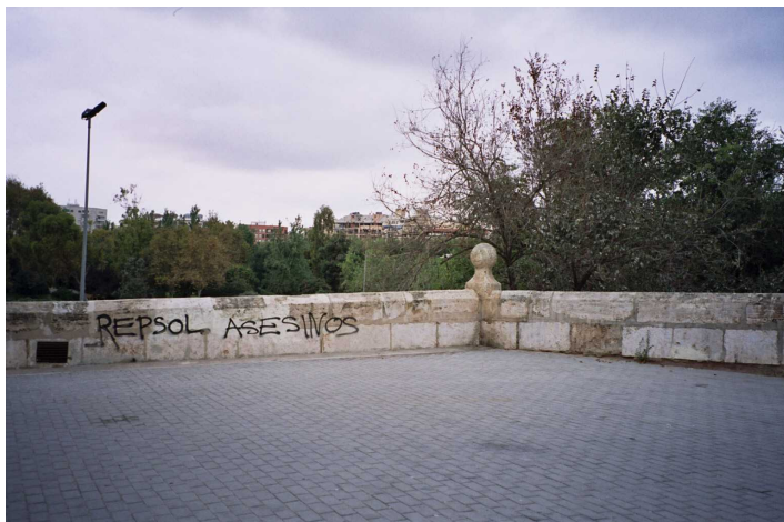
F421. Tramo V Petril correspondiente a Puente de Serranos, entrante cuadrangular con "almena" esférica
