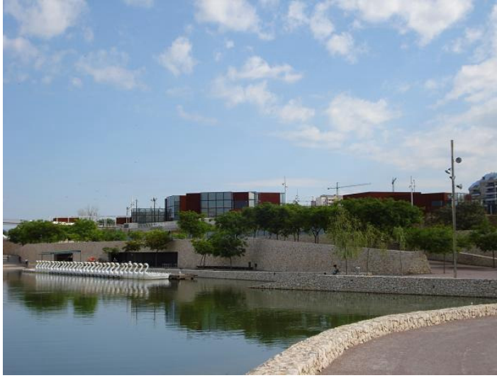
F360. Tramo I edificios de acogida trasera Bioparc
