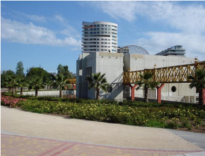
F11. Tramo I Casa del Agua A diseñada por Vetges Tú
