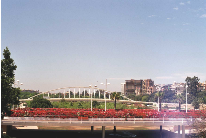
F391 Tramo X Puente de las Flores
