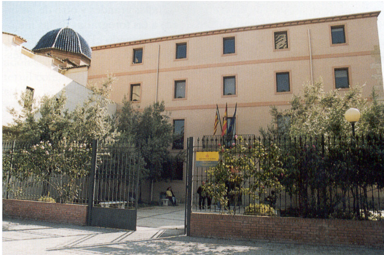
F216 Tramo XI Fachada principal y acceso al Museo Fallero
