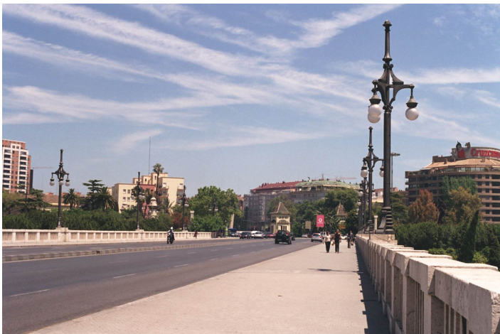
F394. Tramo X Puente de Aragón
