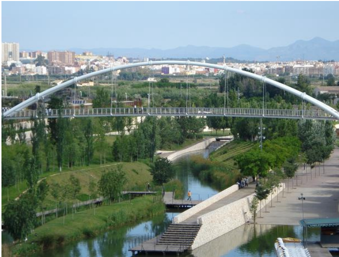
F364. Tramo I Bioparc puente de acceso al parque
