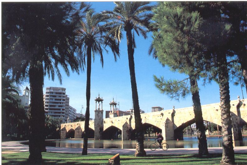
F211 Tramo IX Puente del Mar
