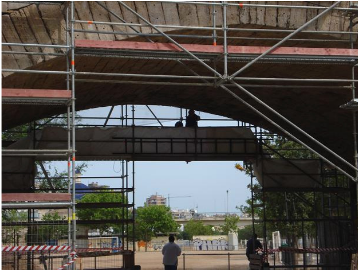
F170. Tramo V Puente de Serranos en restauración lado E. Detalle.
