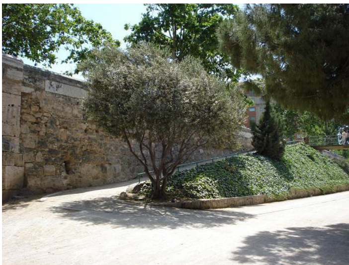
F382. Tramo II Acceso del Puente de Ademuz
