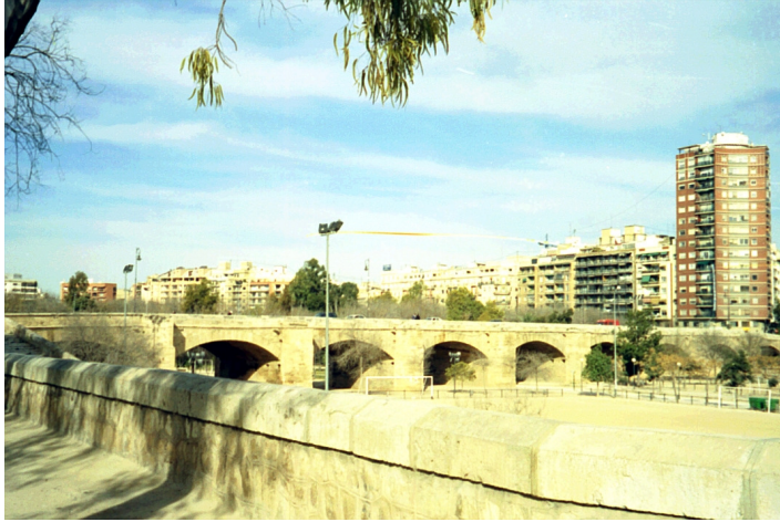
F166. Tramo V Puente de Serranos
