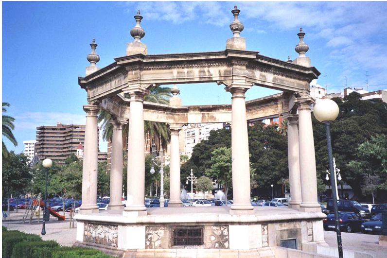
F287. Tramo IX quiosco de música del Paseo de la Alameda en las cercanías del Puente del Real. Al fondo el edificio de la Paoda
