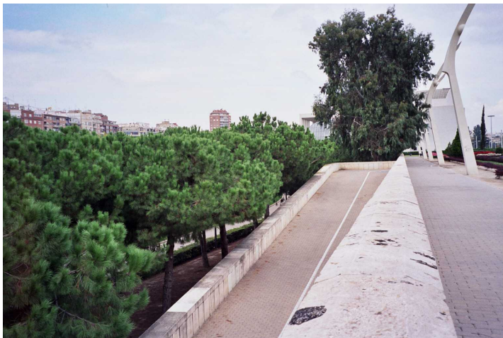
F72 Tramo IX bajada con rampa del Palau de la Música
