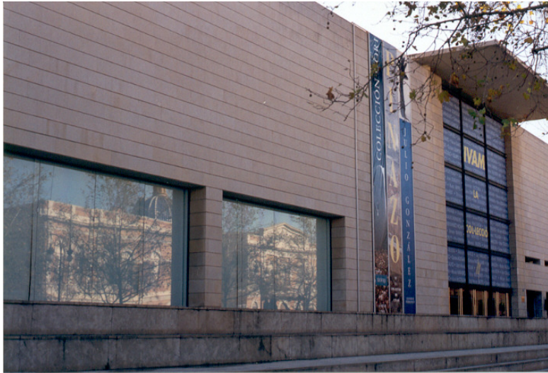
F118. Tramo IV Instituto Valenciano de Arte Moderno
