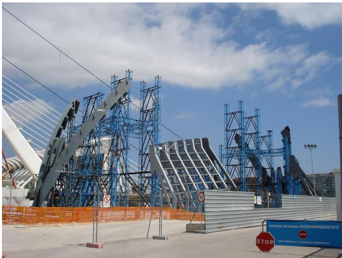
F263. Tramo XI Construcción rascacielos Alicante
