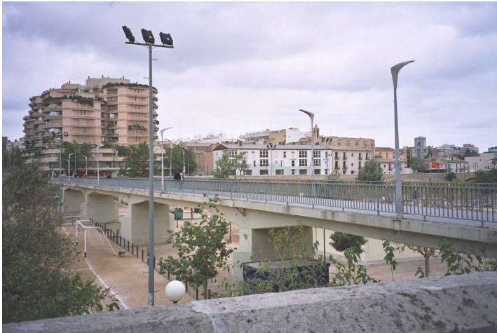
F58. Tramo VI Pont de Fusta, en un futuro será para vehículos
