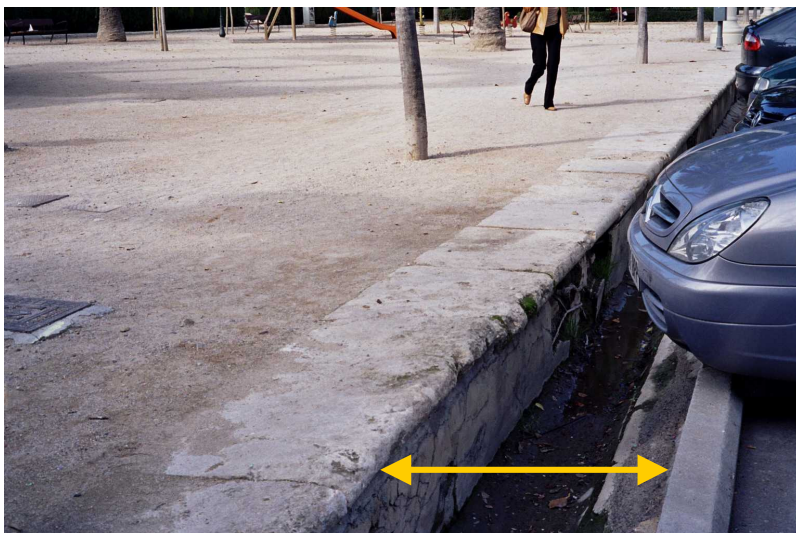
Foto 291 Tramo VIII desnivel de 45 cm entre la zona de paseo y el tráfico rodado en el Paseo de la Alameda cercanías del Puente del Real
