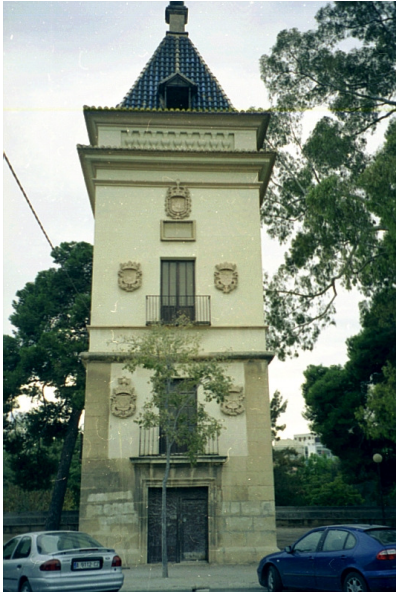
F296. Tramo VIII "Caseta de los Guardas" Original entrada del Paseo de la Alameda
