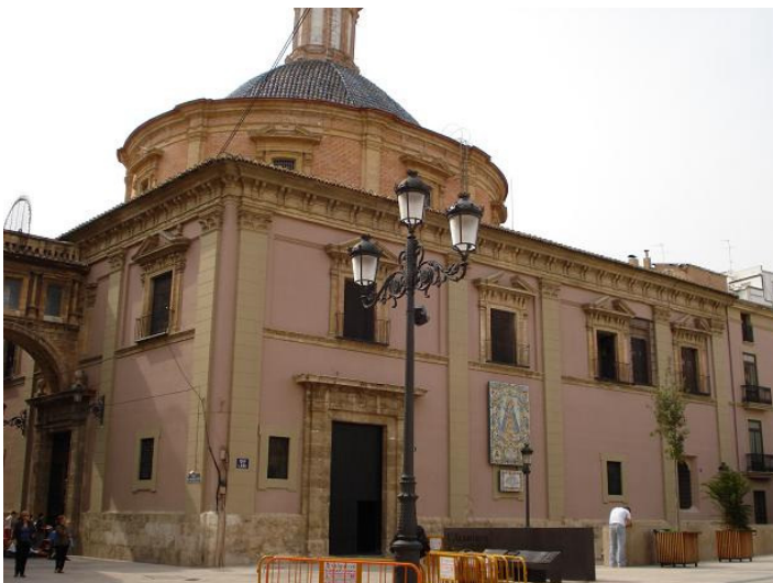
F181. Tramo VI Plaza de la Almoína, Basílica
