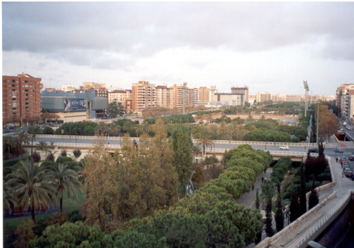
F28. Unión Tramo I y Tramo II, Puente de Campanar
