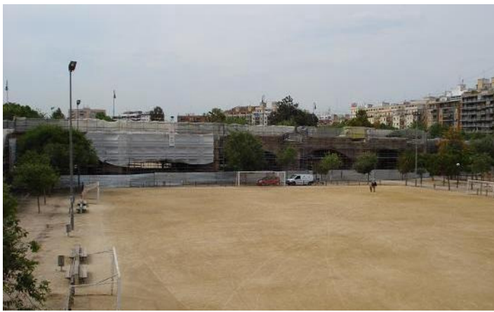
F167. Tramo V Puente de Serranos en restauración
