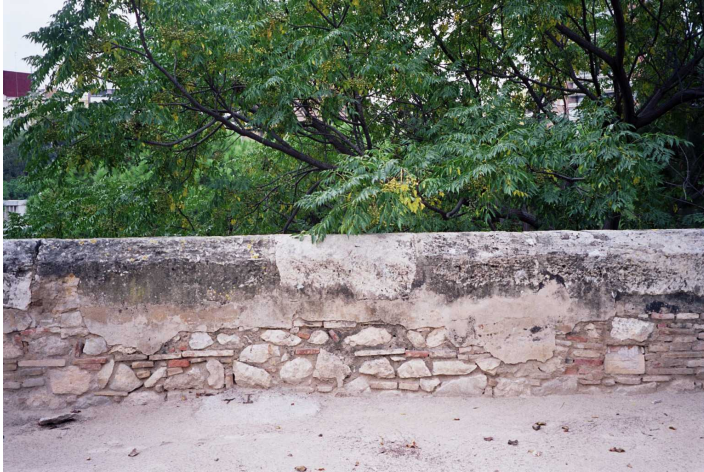
F425. Tramo VIII Petril correspondiente a Puente Aragón
