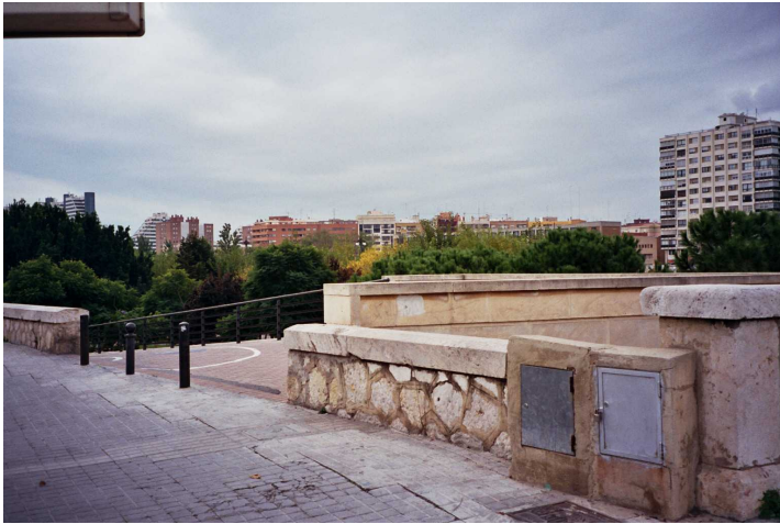
F76. Tramo X bajada del puente del Ángel Custodio
