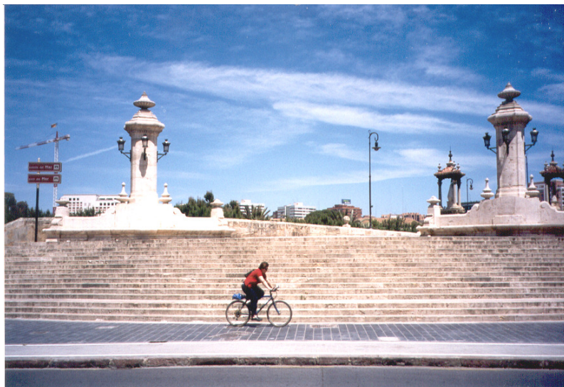
F212 Tramo IX escalinata del Puente del Mar
