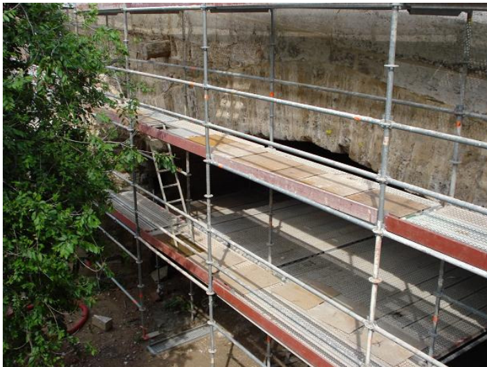
F190. Tramo VII Puente de la Trinidad, detalle de restauración
