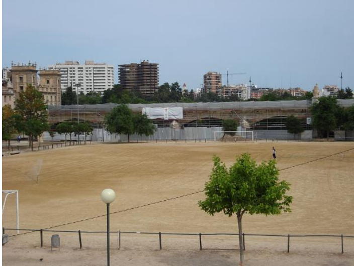
F188. Tramo VII Puente de la Trinidad, en restauración
