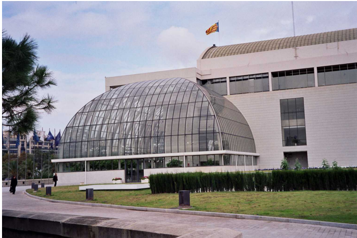
F265. Tramo X Fachada lateral del Palau de la Música
