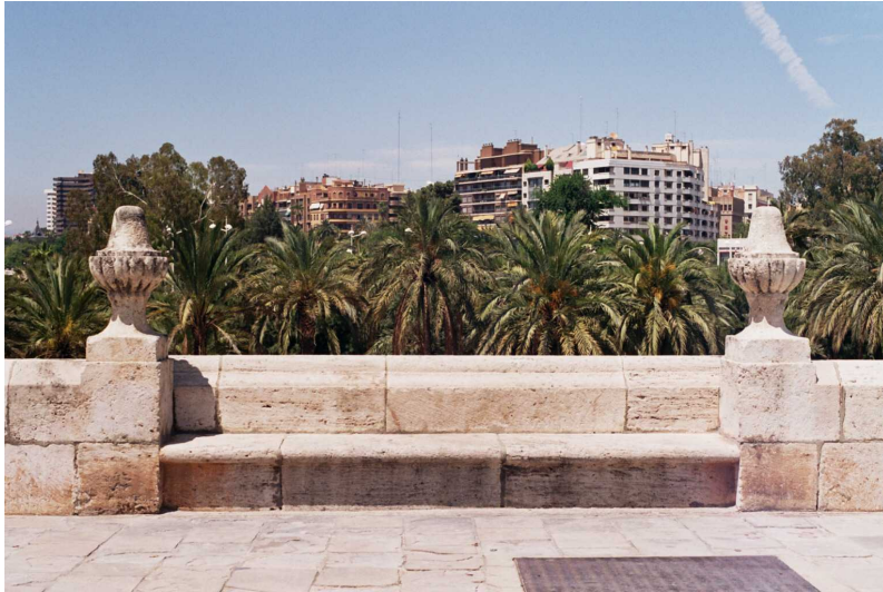
F210 Tramo IX canapé del Puente del Mar
