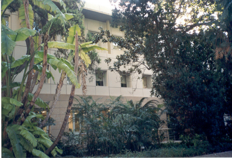
F99 Tramo II Fachada interior del edificio Multiusos del
