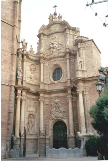
F185. Tramo VI Puerta de los Hierros de la Catedral en la Plaza de la Reina
