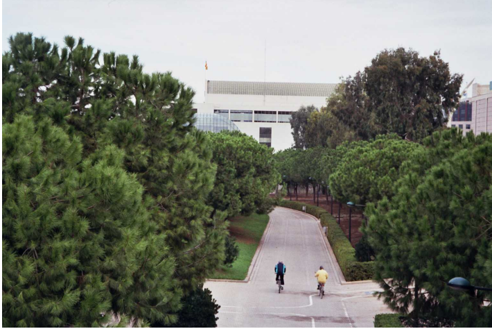
F70. Tramo IX calzada lateral adoquinada con carril bici
