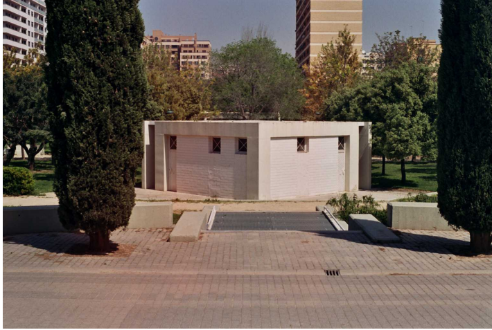
F16. Tramo I estructura cafetería, hoy en desuso diseño Vetges Tú
