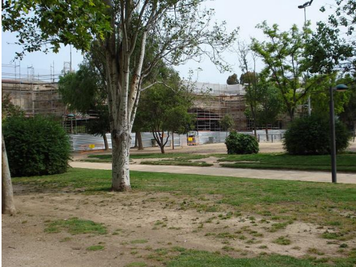
F169. Tramo V Puente de Serranos en restauración lado W
