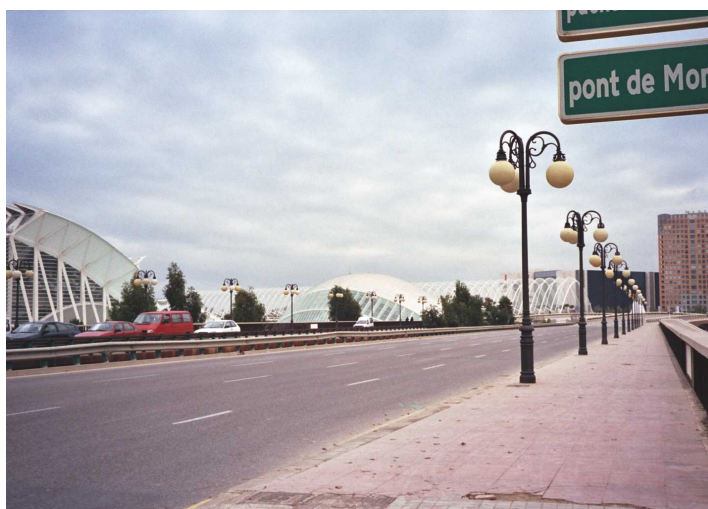
F410 Tramo XI Puente de Monteolivete
