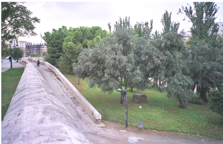
F135 Tramo V bajada del Puente de San José, vista opuesta
