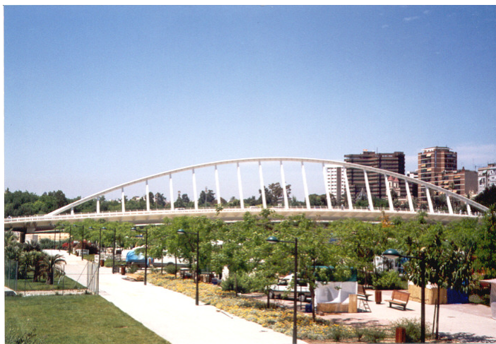
F388. Tramo IX Puente de las Artes
