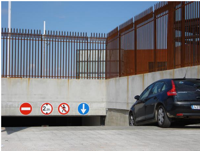
F352. Tramo I Acceso individual Bioparc
