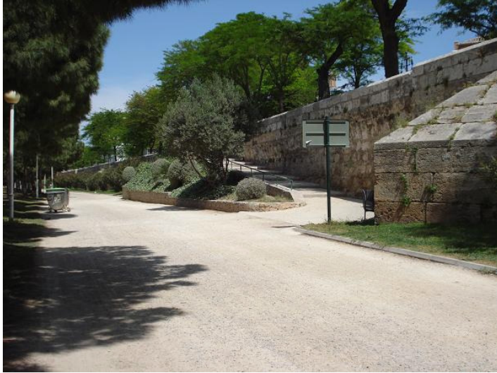
F36. Tramo III Rampa de acceso al IVAM
