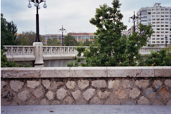
F428. Tramo X Petril correspondiente a Puente del Reino
