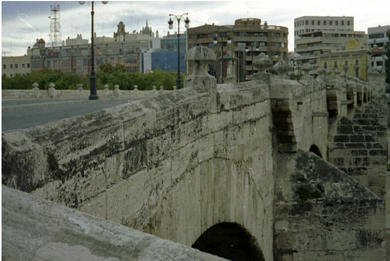
F198. Tramo VII Puente del Real, detalle
