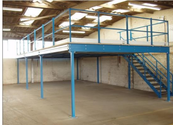
Figura 30. Colocación escalera en la plataforma lateral del taller.
