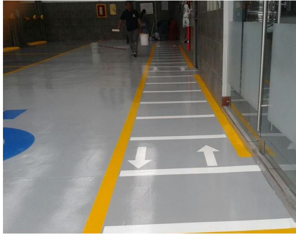
Figura 29. Señalización del paso entre recepción y oficina.
