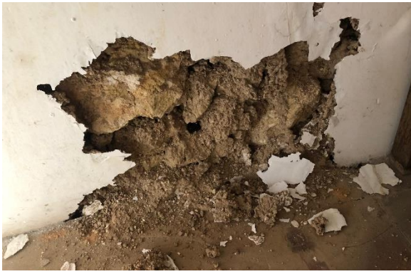
Imagen 45. Cata Muro de Carga. Fuente Propia.
