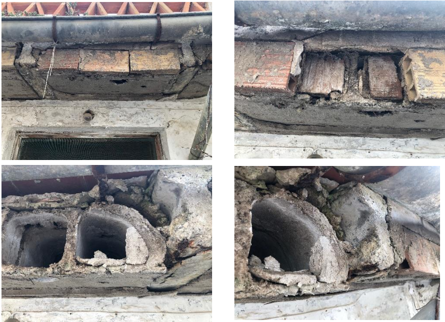
Imagen 41. Canto Forjado Planta Primera. Fuente Propia.
