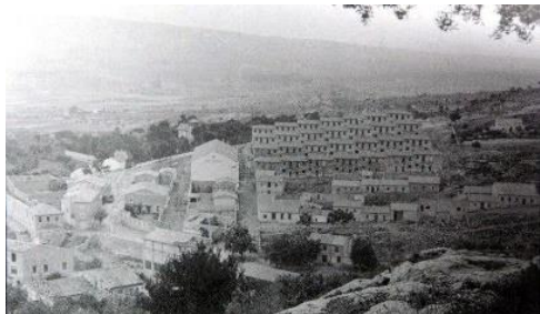
Imagen 8. Les Casetes Noves en Construcción. Autor Desconocido.
