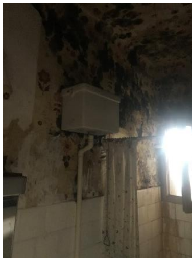
Imagen 22. Baño. Fuente Propia.
