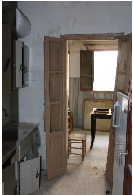
Imagen 18. Acceso Cocina-Comedor. Fuente Propia.
