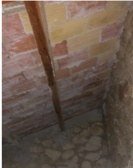
Imagen 50. Cubierta Dormitorio 4. Fuente Propia.
