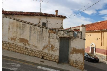
Imagen 14. Fachada Posterior. Fuente Propia.
