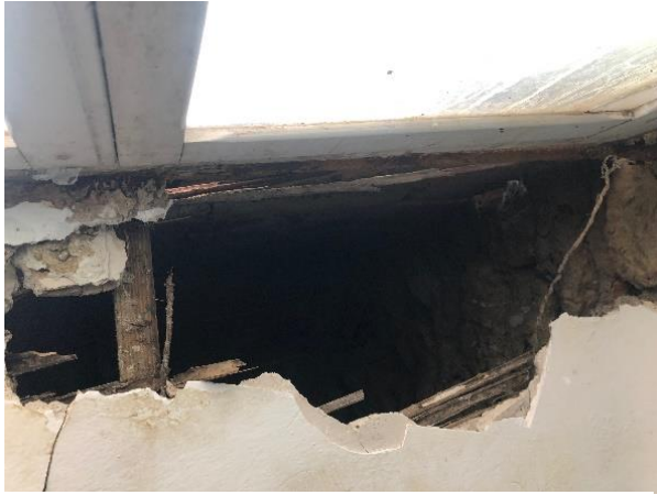
Imagen 49. Retirada Falso Techo. Fuente Propia.
