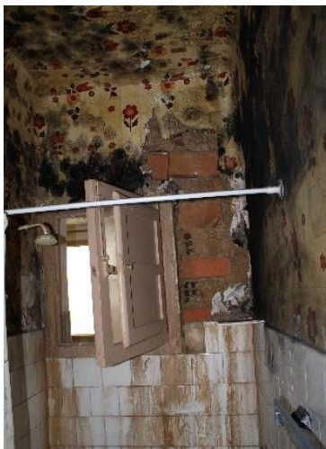
Imagen 21. Baño. Fuente Propia.
