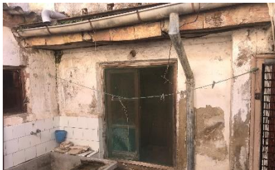
Imagen 68. Canto del Forjado.
