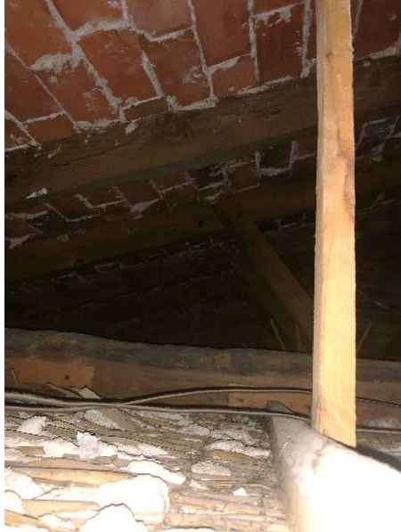
Imagen 47. Cubierta. Fuente Propia.
