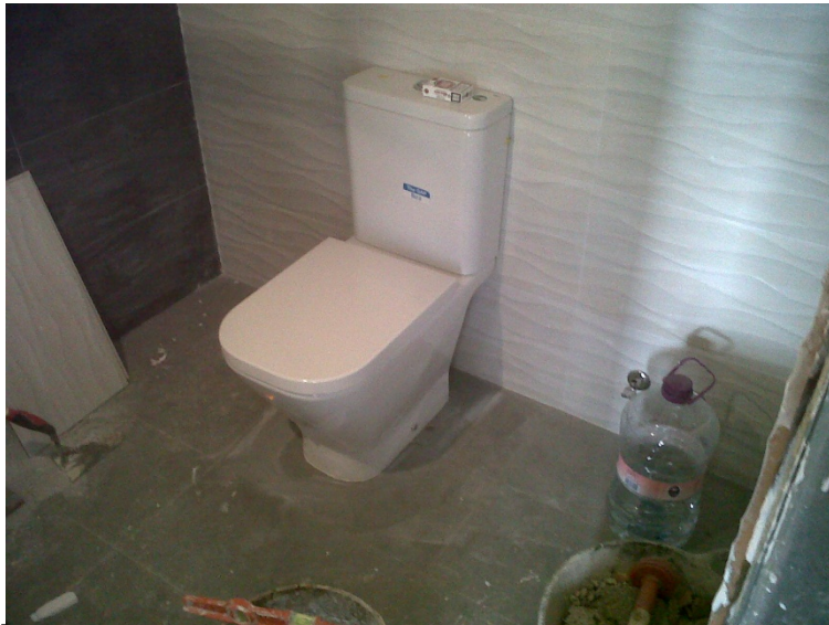
13.2 Colocación de sanitarios.
