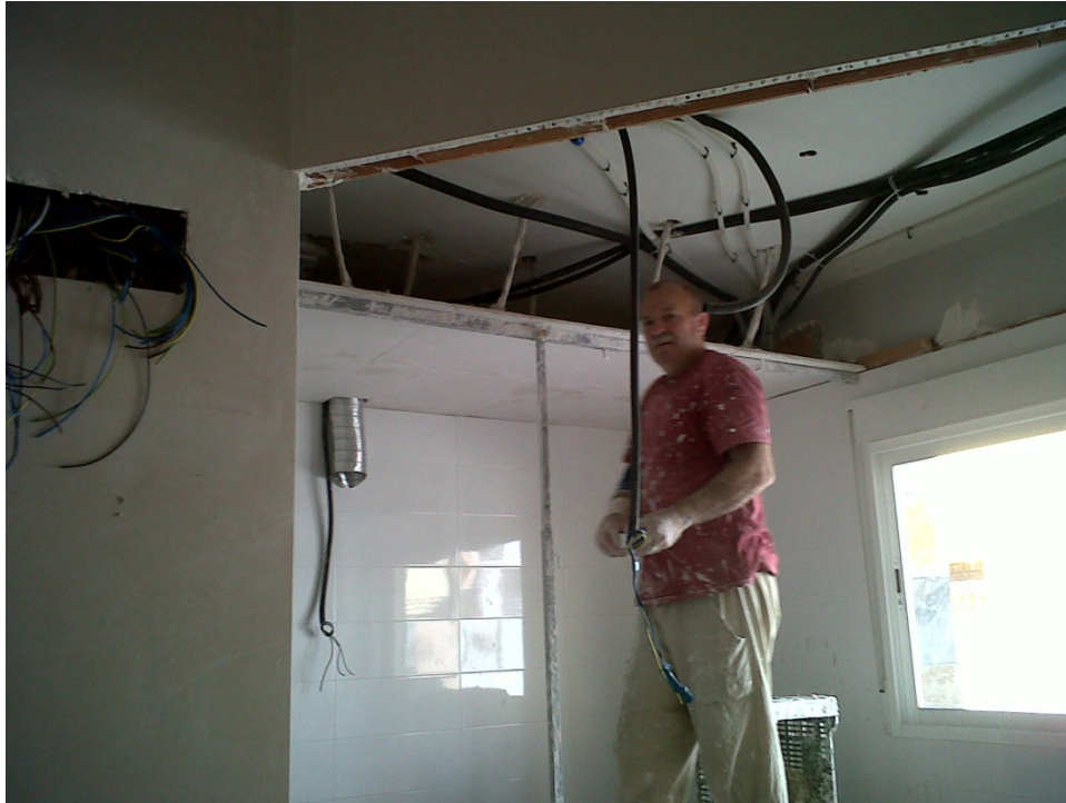
12.2 Ejecución de falsos techos.
