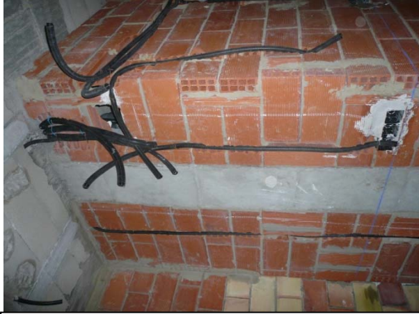
3.4 Instalación de electricidad.
