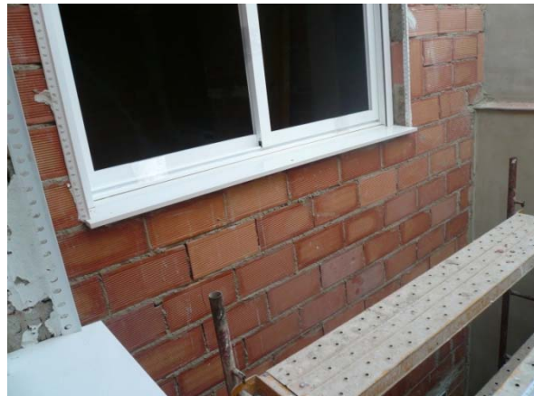
5.7 Colocación carpintería exterior.
