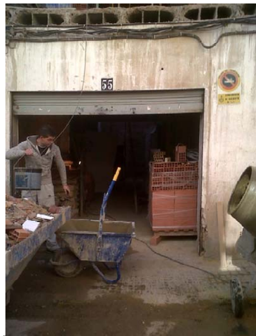
1.3 Hormigonera situada en la calle.
