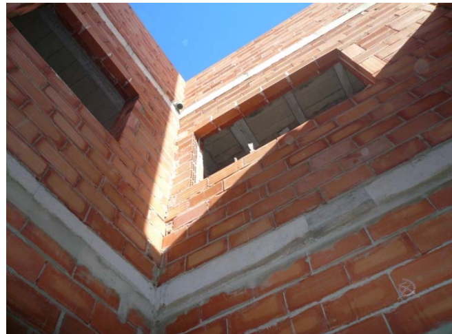
1.14 Vista de fachada del patio interior.
