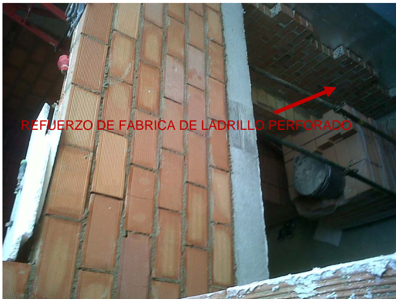
1.7 Refuerzo de fábrica ladrillo perforado.
