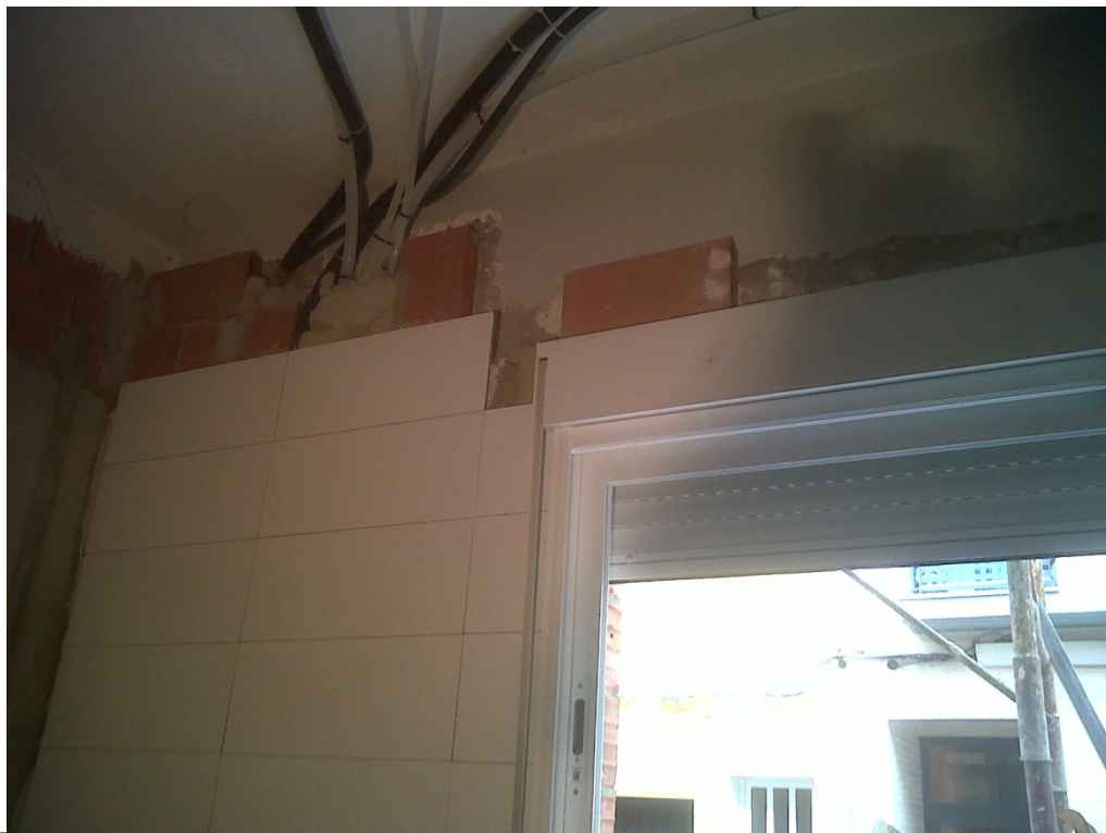
9.1 Alicatado de cocina.
