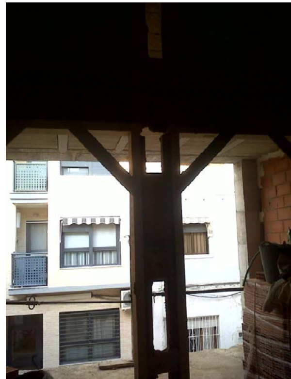
2.5 Tabiquería interior y medidas de seguridad en fachada.
