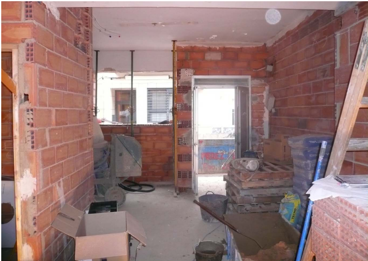
3.1 Apertura de rozas para el paso de instalaciones.
