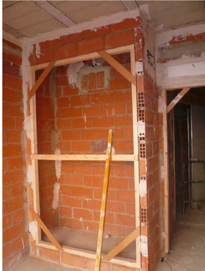
5.3 Armario empotrado de obra.
