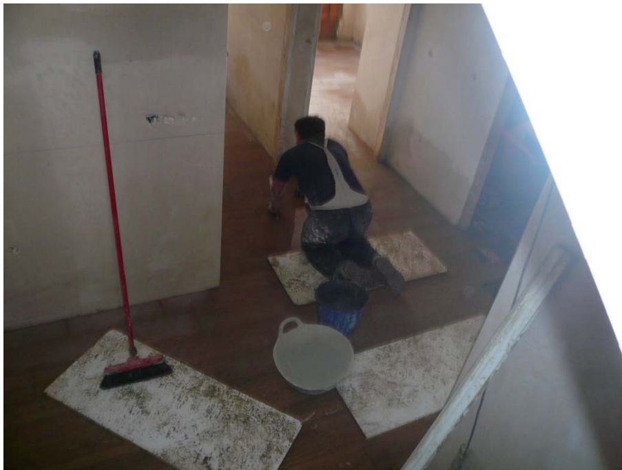
7.4 Colocación del pavimento del interior de la vivienda.
