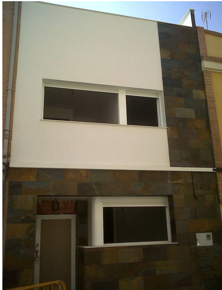
13.1 Monocapa fachada principal.
