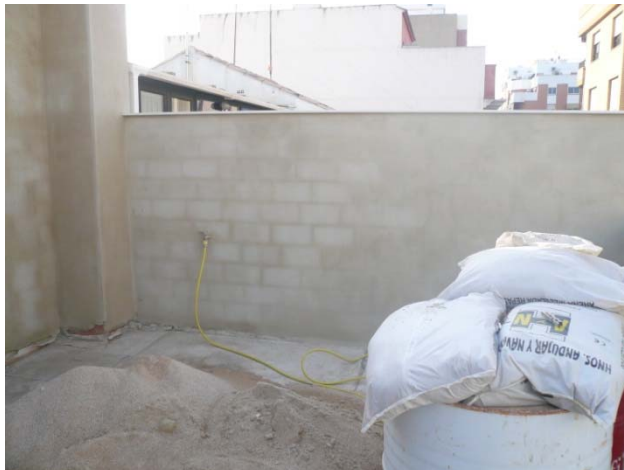
6.1 Enfoscado de fachada.
