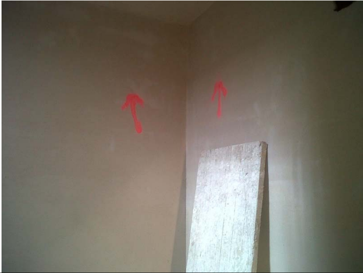
6.7 Señalización con flechas de las zonas a picar.
