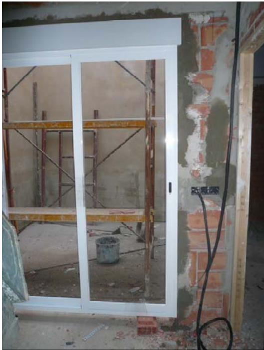
5.6 Colocación carpintería exterior.
