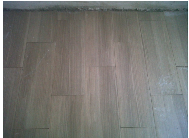
10.2 Pavimento de planta baja.
