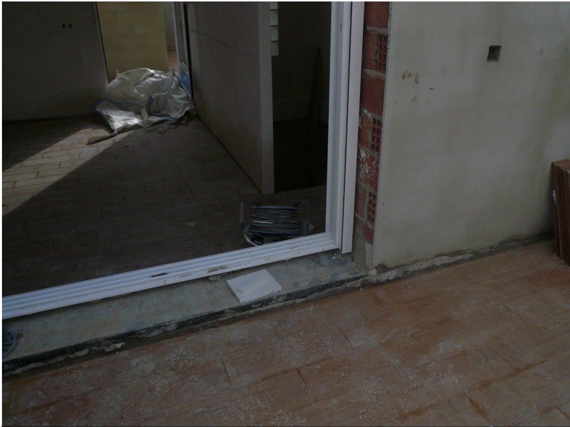
8.2 Colocación del pavimento del interior y exterior de la vivienda.
