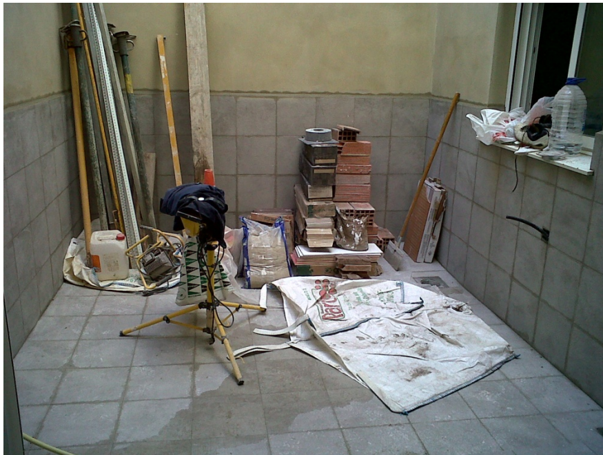
10.4 Chapado del patio interior.
