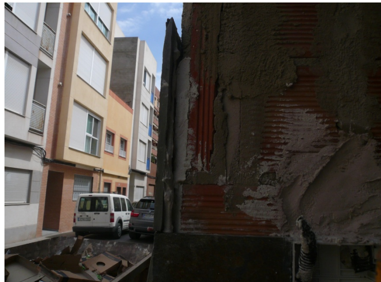
10.5 Chapado de la fachada principal.
