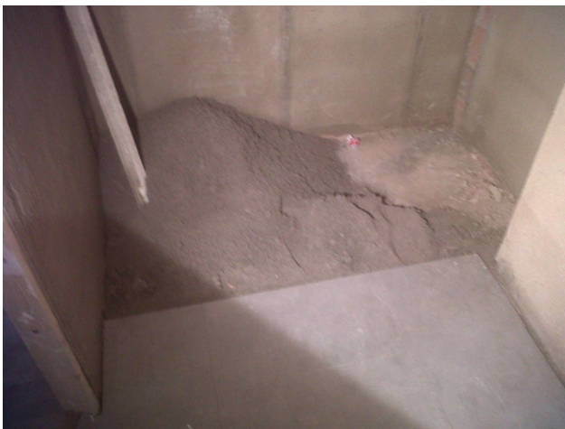
8.4 Pavimento baño 1ª planta.
