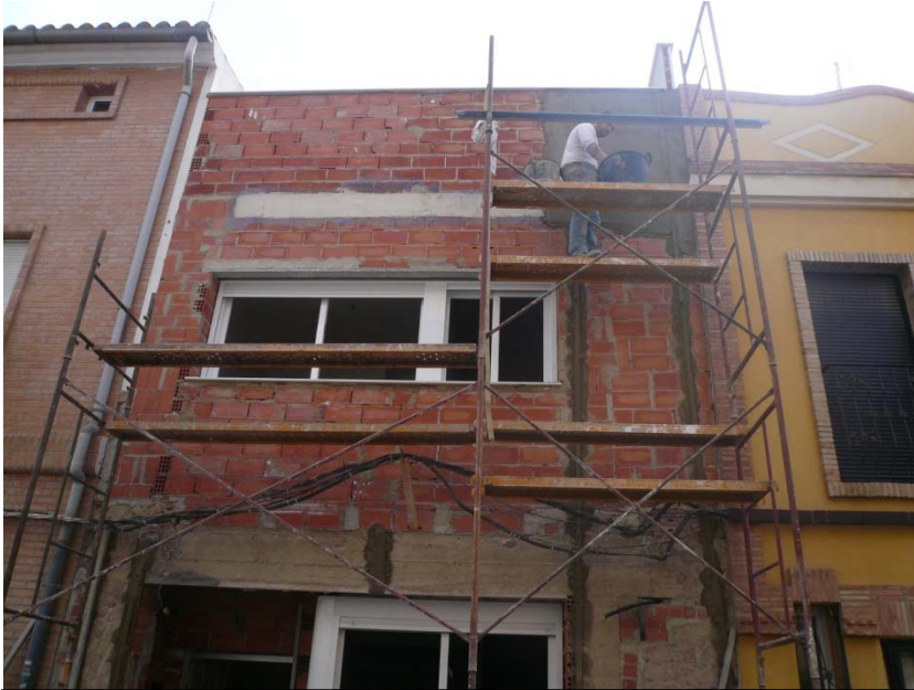
7.2 Enfoscado maestreado de la fachada principal.
