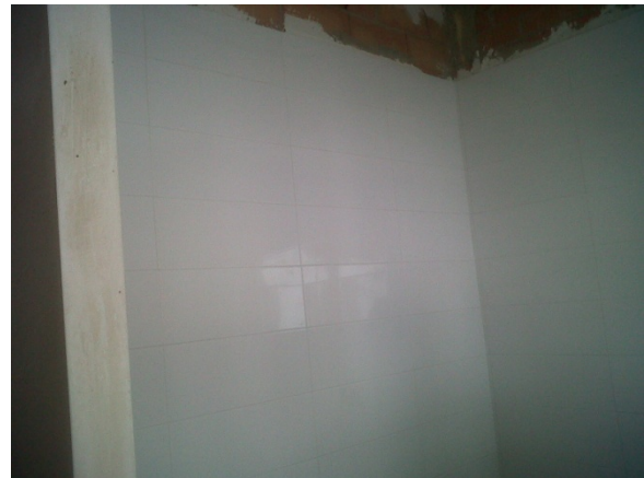
9.6 Alicatado de cocina.
