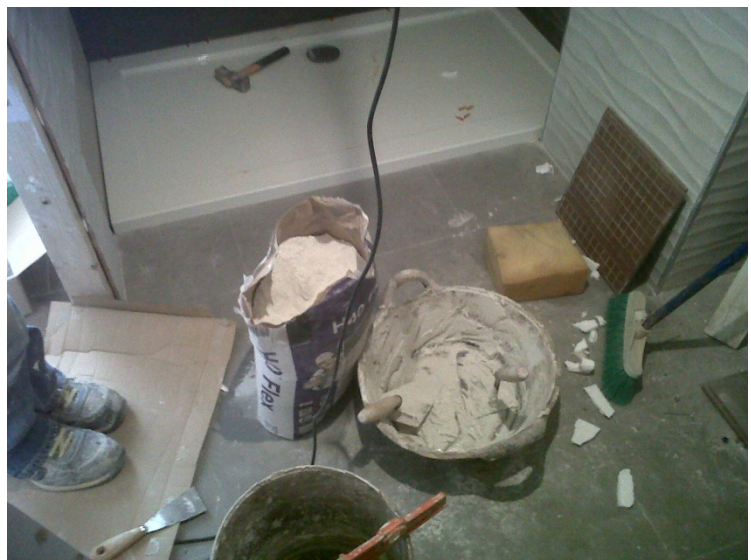
13.3 Colocación de sanitarios.
