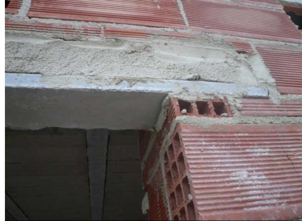
2.8 Detalle de dintel en huecos de fachada.
