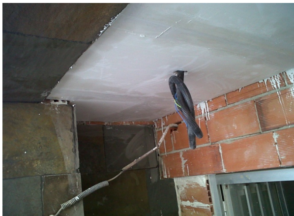
12.4 Ejecución de falsos techos.
