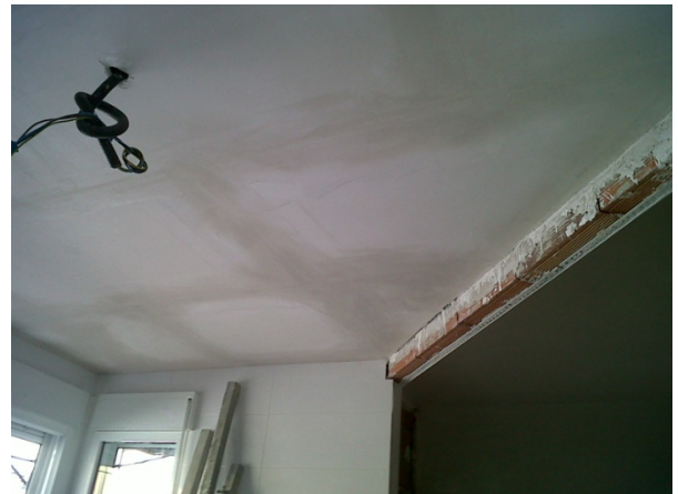
12.4 Ejecución de falsos techos.
