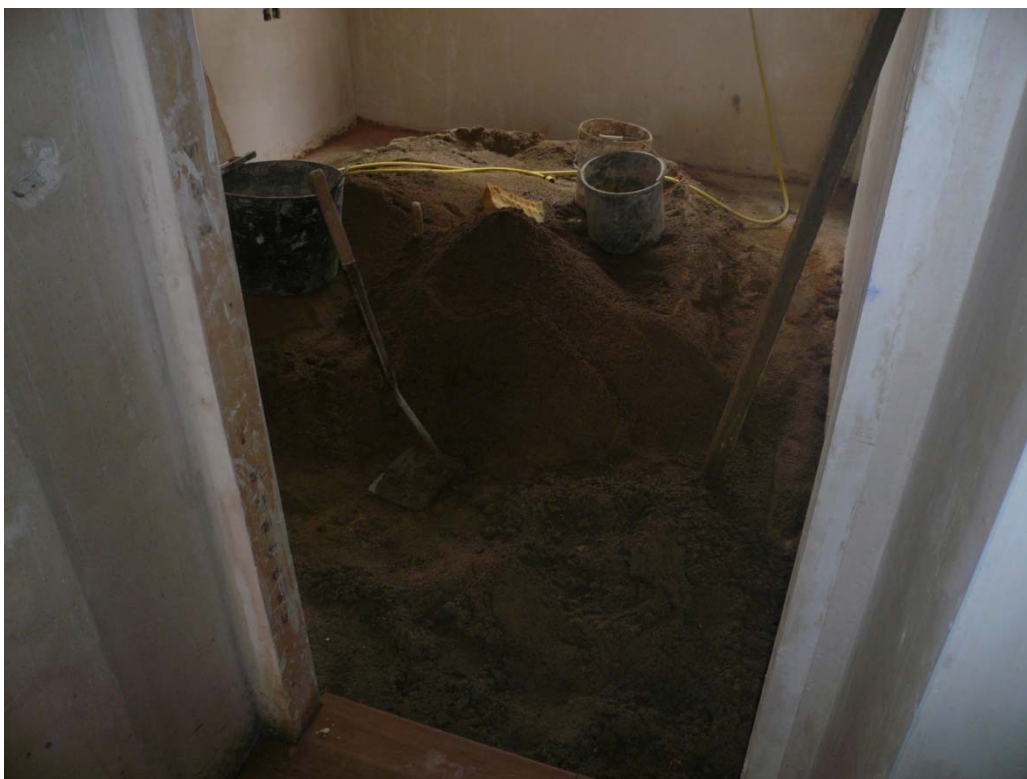
7.5 Colocación del pavimento del interior de la vivienda.
