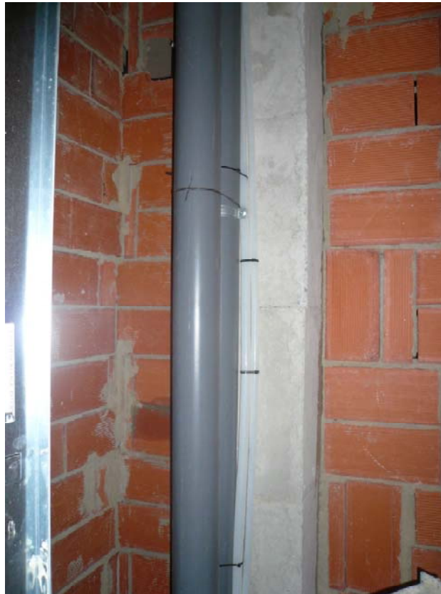
3.6 Bajantes de saneamiento.
