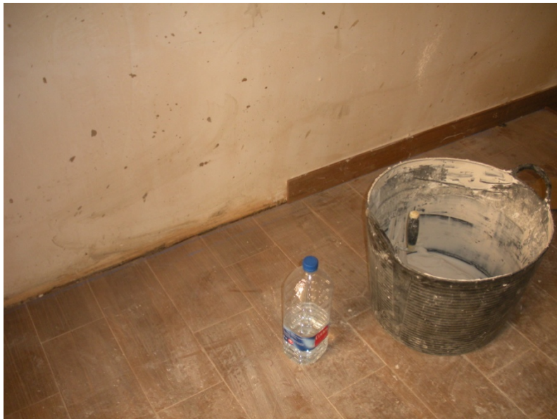
13.5 Colocación del rodapié.
