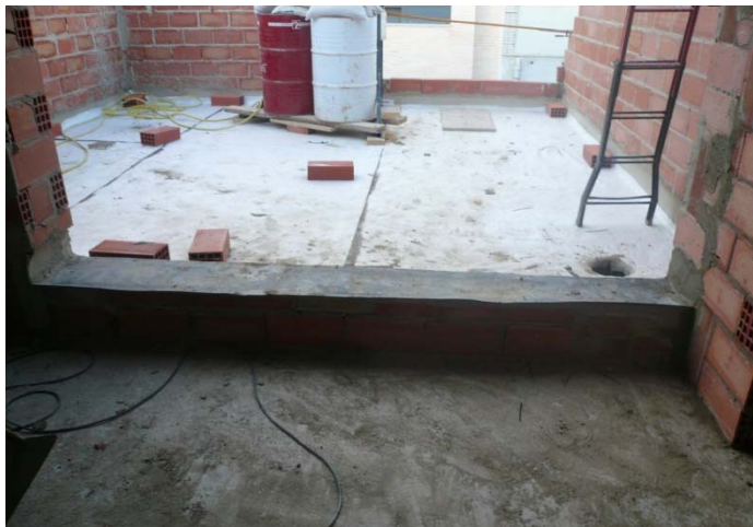
5.1 Estado actual de las cubiertas.
