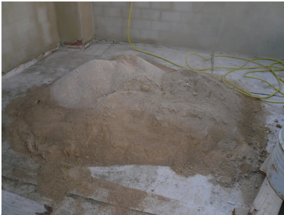
8.1 Colocación del pavimento del interior y exterior de la vivienda.
