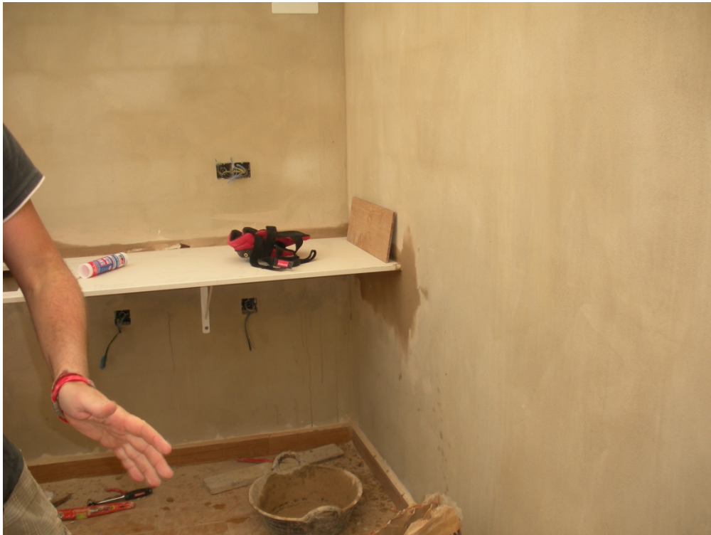
13.4 Colocación de de la encimera del fregadero de la cubierta transitable.
