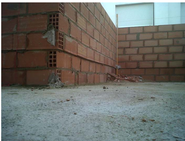
2.10 Ejecución del antepecho.
