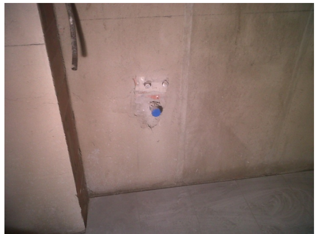
8.5 Pavimento baño 1ª planta.
