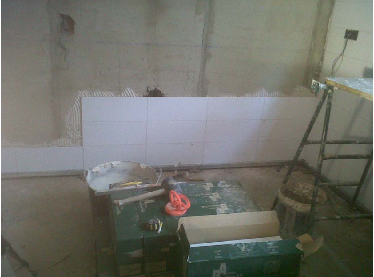
9.2 Alicatado de cocina.
