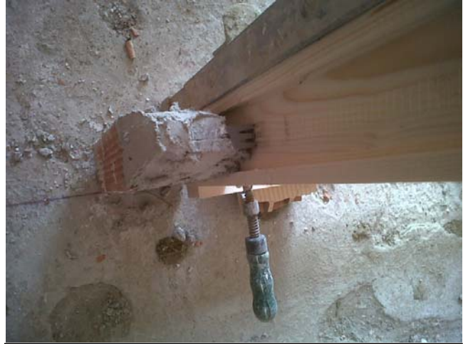
1.10 Detalle falcado del premarco.
