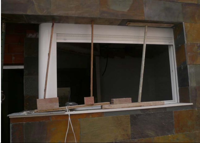
11.2 Chapado de la fachada principal.
