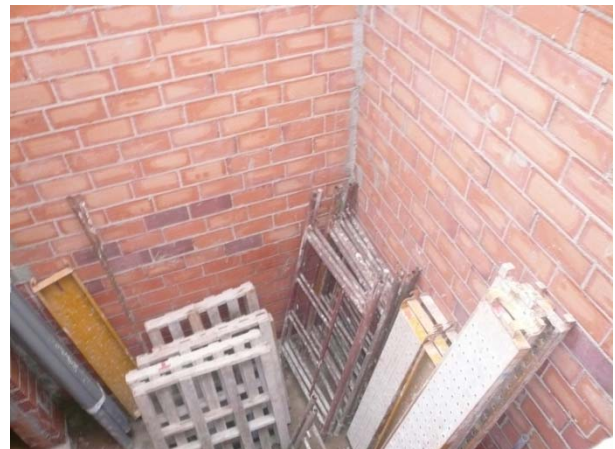
2.2 Medianera de patio interior.
