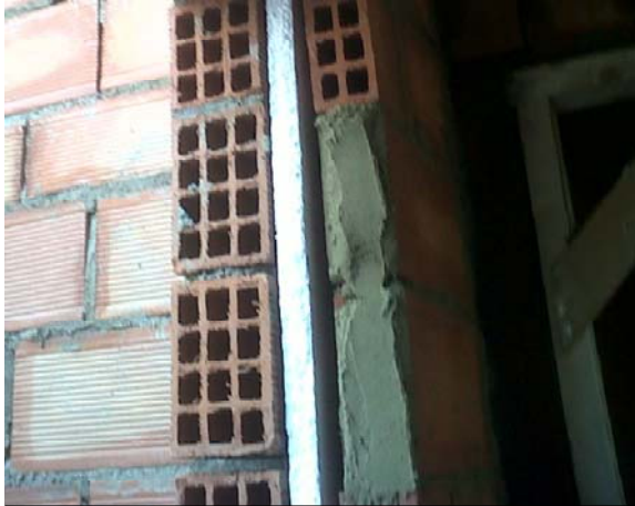
1.12 Aislamiento y cámara de aire en fachada.
