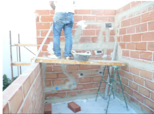
5.5 Colocación de cantoneras.
