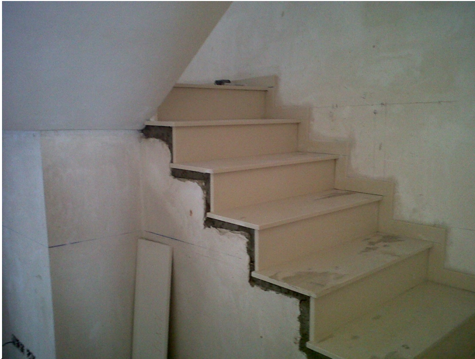
11.3 Revestimiento de la escalera.
