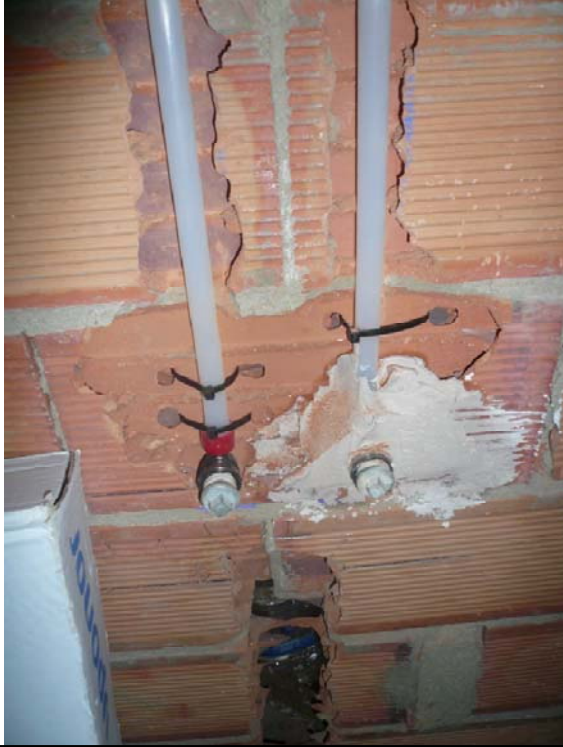
3.2 Instalación de fontanería.
