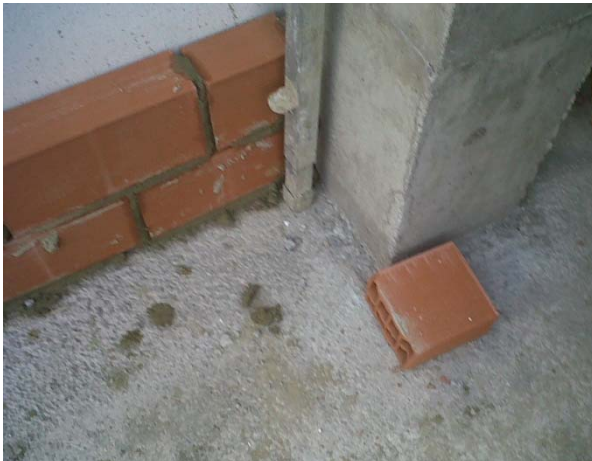
2.1 Ejecución medianera 2ª planta.
