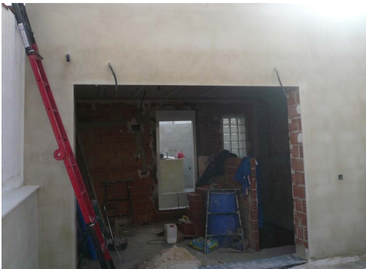
5.9 Colocación carpintería exterior.
