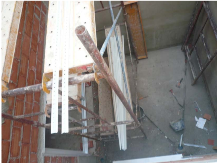
5.4 Enfoscado fachadas exteriores del edificio.
