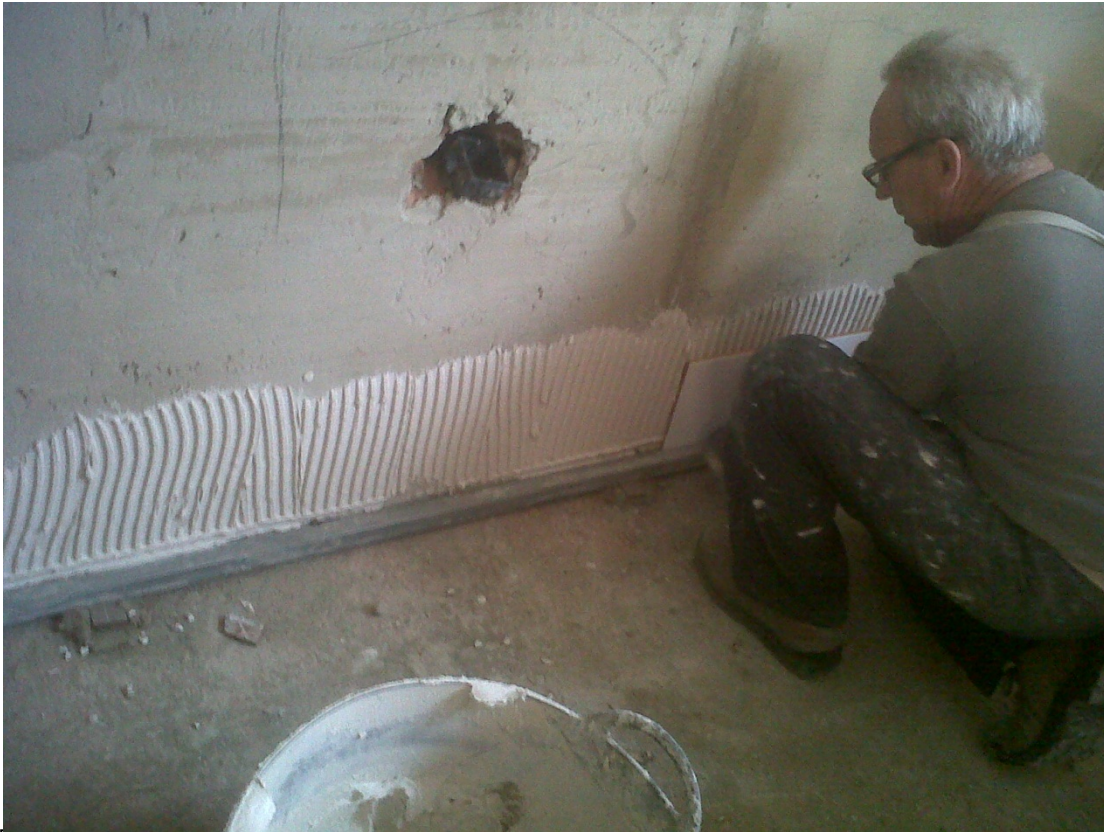
8.5 Alicatado de cocina.
