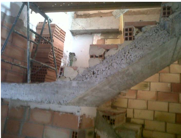
1.5 Ejecución de medianera.
