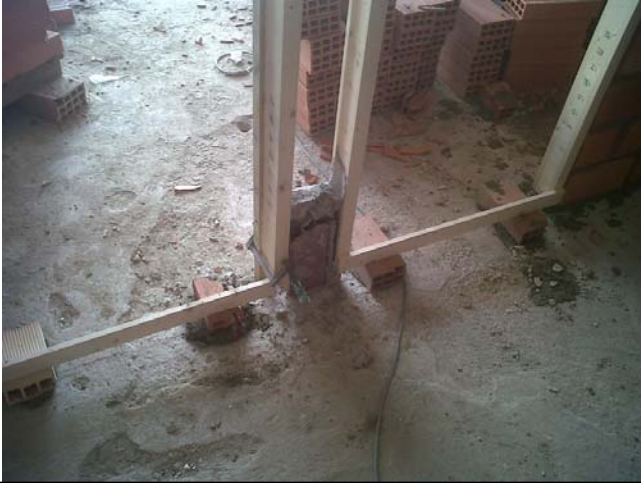
1.9 Ejecución de particiones interiores.
