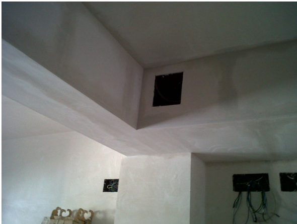
12.3 Ejecución de falsos techos.
