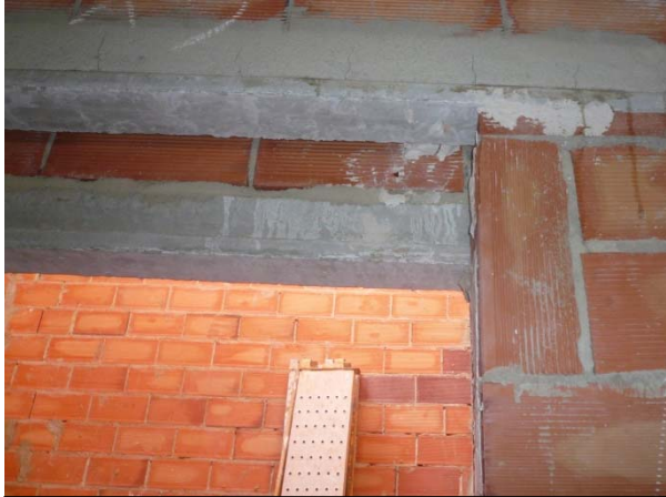
2.6 Detalle de dintel en huecos de fachada.
