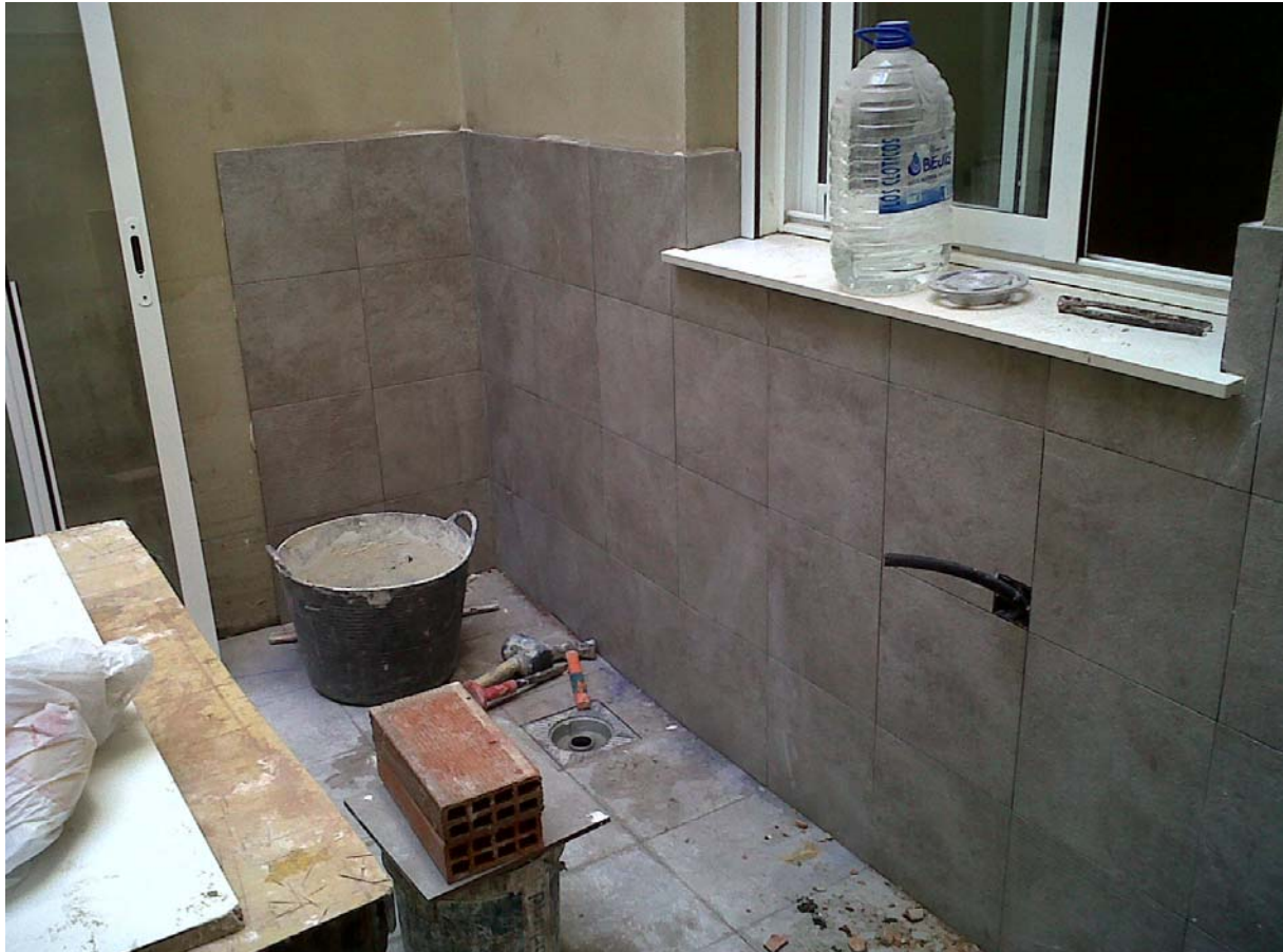
10.3 Alicatado del patio interior.
