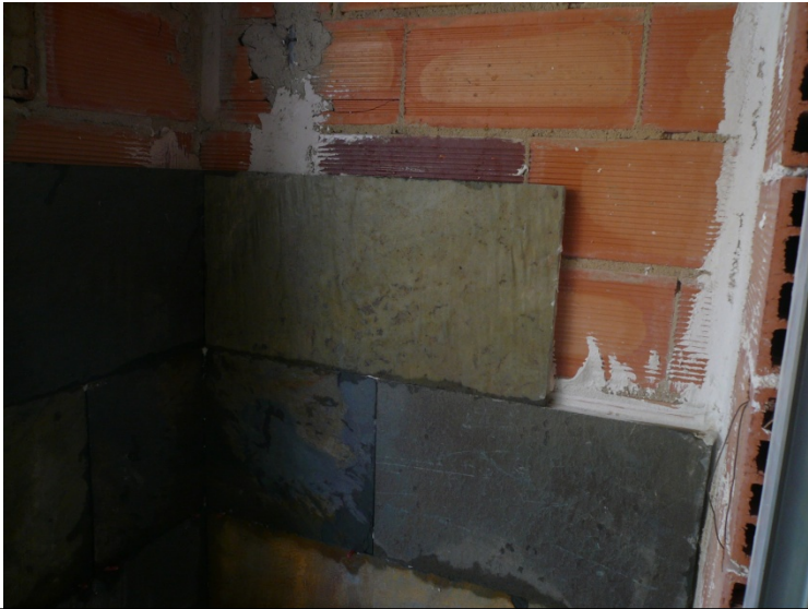
10.5 Chapado de la fachada principal.
