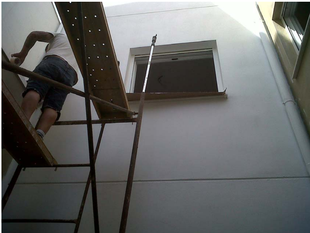
12.1 Pintura del enfosado de fachada del patio interior.
