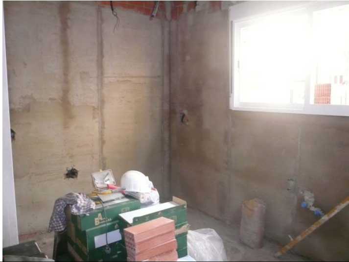
7.3 Enfoscado maestreado de la cocina.
