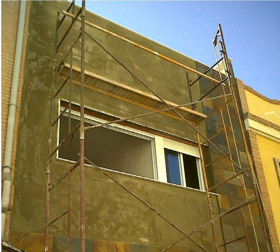
12.4 Enfoscado maestreado de fachada.
