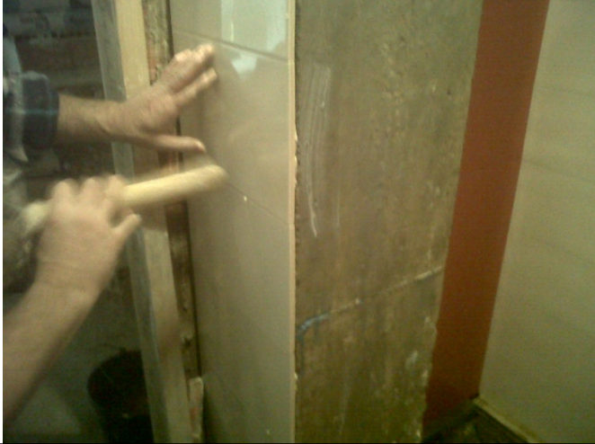
9.3 Chapado de pilares en baños.
