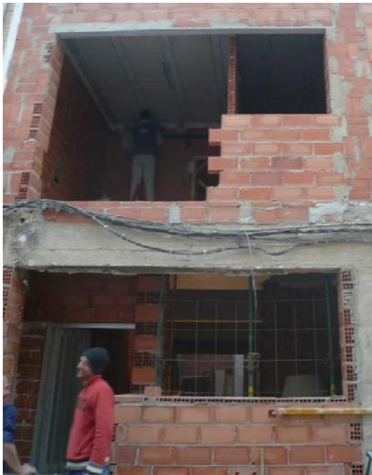
1.13 Vista de fachada desde la calle.
