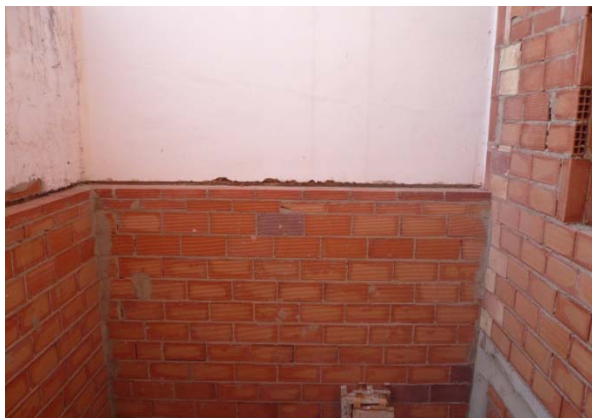
2.3 Remate superior medianera patio interior.
