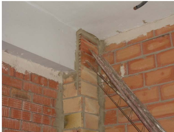
1.8 Refuerzo de viga con fabrica de ladrillo perforado.
