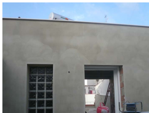
6.2 Enfoscado de fachada.
