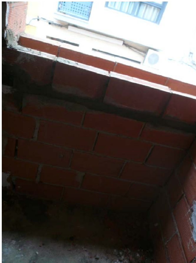
1.11 Ejecución de la fachada principal.
