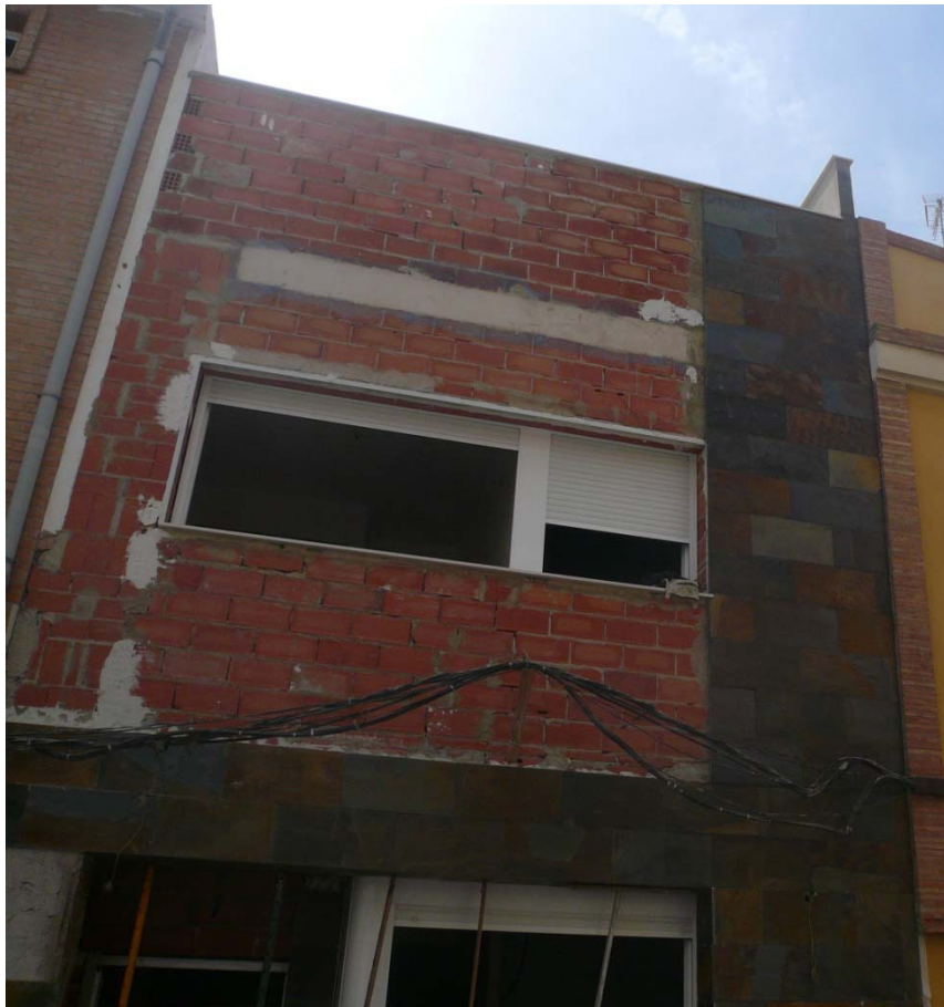
11.1 Chapado de la fachada principal.
