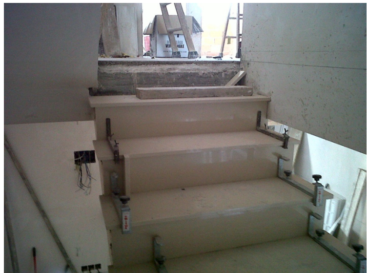
11.2 Revestimiento de la escalera.
