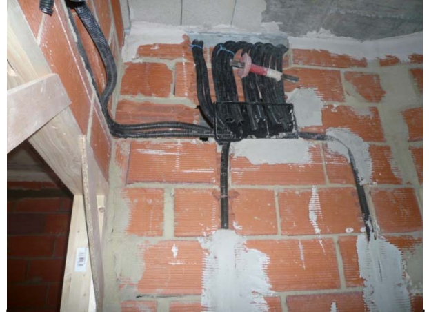
3.5 Instalación de electricidad.
