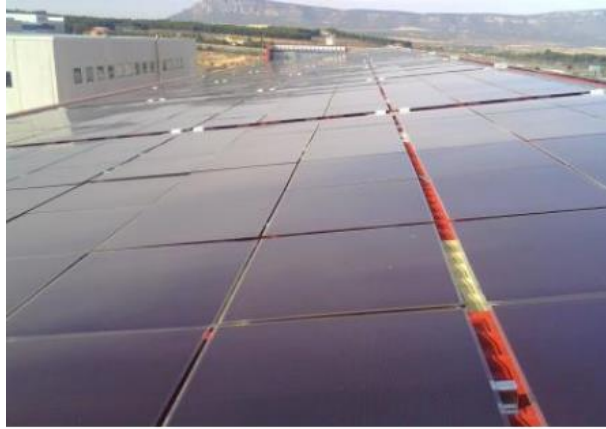
Figura 13. Colocación de módulos sobre el soporte elegido. Fuente: www.solarstem.com
