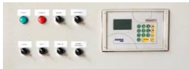
Figura 8. Detalle de la pantalla del programador Agronic 2500
