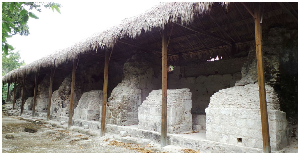
Fig. 4.7 fachada exterior del ala sur de la Acrópolis donde se observan los vanos de entrada a los distintos cuartos.
