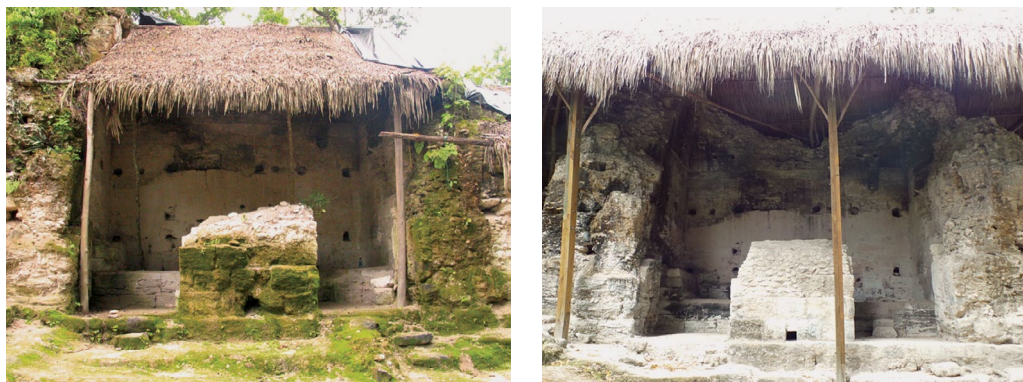
Fig. 6.9 Cuarto 6J2-4 en 2008 y 2016; la primera cubierta de protección era pequeña, por lo que el edificio quedaba exhibido a la lluvia, desencadenándose la proliferación de microorganismos en las zonas más expuestas. Tras la modificación de la cubierta, con más proyección y altura, no se han vuelto a producir estos daños biológicos.
