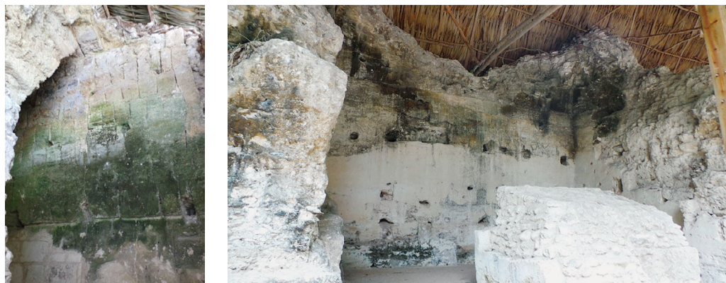
Fig. 4.37 Concreciones microbiológicas sobre los estucos de las bóvedas que quedaron expuestas a la intemperie durante el periodo de abandono del sitio.
