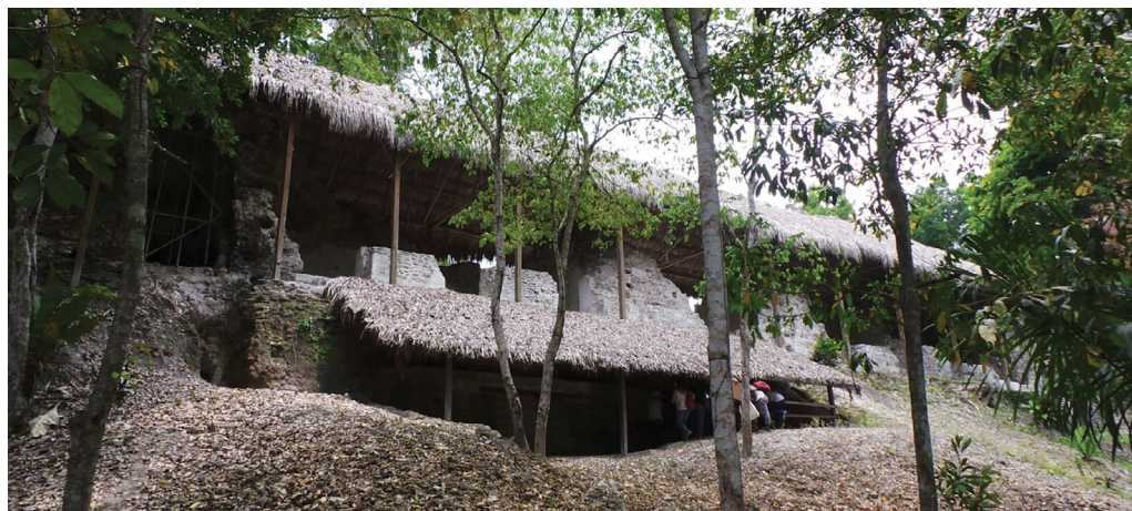
Fig. 4.9 Fachada exterior oeste donde se aprecian los distintos cuartos del ala oeste y sus vanos de entrada.
