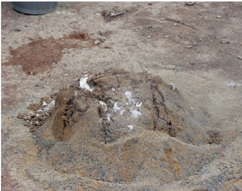
Fig. 3.13 Mezclado de la arena con la cal y agua, dejando que aumente la temperatura de la reacción. Fig.3.14 Destapado del montículo y adición de más agua para completar la elaboración del mortero.
