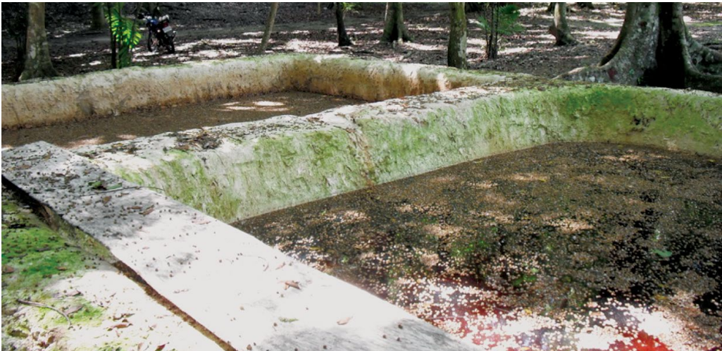
Fig. 3.15 Adición del fruto del Ramón ( Brosimum Alicastrum ) en el agua de apagado de la cal por inmersión. Método empleado en los trabajos de conservación en el sitio arqueológico de Naranjo, Petén.
