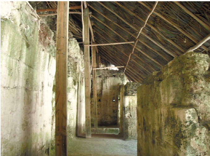
Fig. 4.24 Cuarto 6J2-3 en 2013 al crearse filtraciones en la cubierta deteriorada. Fotografía B. Carrascosa. Fig. 4.25 Cuarto 6J2-3 en 2016; después de limpiar las concreciones biológicas y reponer la cubierta, los estucos se mantienen en buen estado. Fig.4.26 Cuarto 6J2-7 en 2013 fuertemente atacado por microorganismos. Fig. 4.27 Cuarto 6J2-7 en 2016, tras la limpieza y reposición de cubierta, se han revertido las concreciones, manteniéndose hasta la fecha en buen estado.
