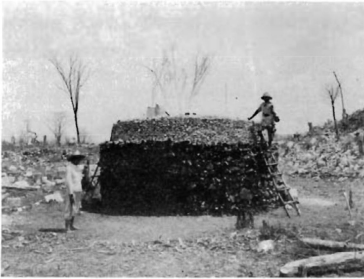
Fig. 3.9 Calera de madera circular con piedra caliza dispuesta para quemar. Fuente Morris et.al 1931
