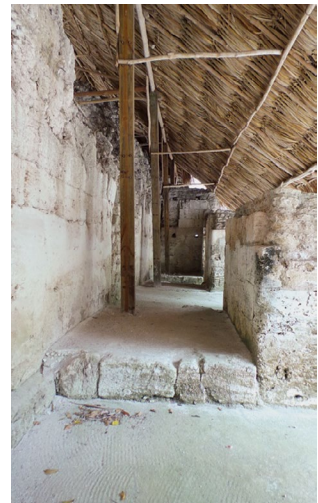
Fig. 4.24 Cuarto 6J2-3 en 2013 al crearse filtraciones en la cubierta deteriorada. Fotografía B. Carrascosa. Fig. 4.25 Cuarto 6J2-3 en 2016; después de limpiar las concreciones biológicas y reponer la cubierta, los estucos se mantienen en buen estado. Fig.4.26 Cuarto 6J2-7 en 2013 fuertemente atacado por microorganismos. Fig. 4.27 Cuarto 6J2-7 en 2016, tras la limpieza y reposición de cubierta, se han revertido las concreciones, manteniéndose hasta la fecha en buen estado.
