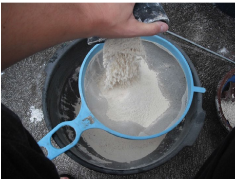
Fig. 5.8 Arena blanca. Tamizado del árido para la preparación del mortero. Fig. 5.9 Sascab . Tamizado del árido para la preparación del mortero.
