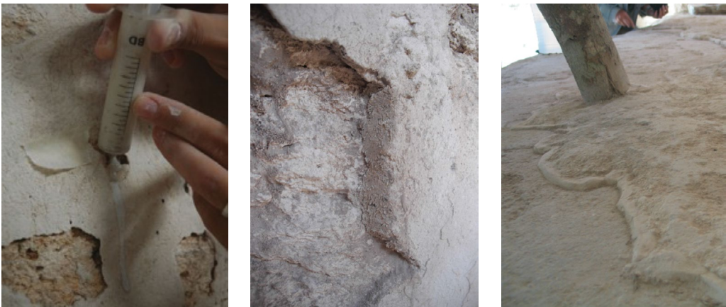
Fig. 4.41 Consolidación interna de un abolsamiento mediante PLM-A ® . Fig. 4.42 Reborde perimetral de estuco sobre paramento vertical. Fig. 4.43 Reborde perimetral de refuerzo de los estratos de estuco horizontales de la banqueta central de 6J2-2. Fotografías: B. Carrascosa.
