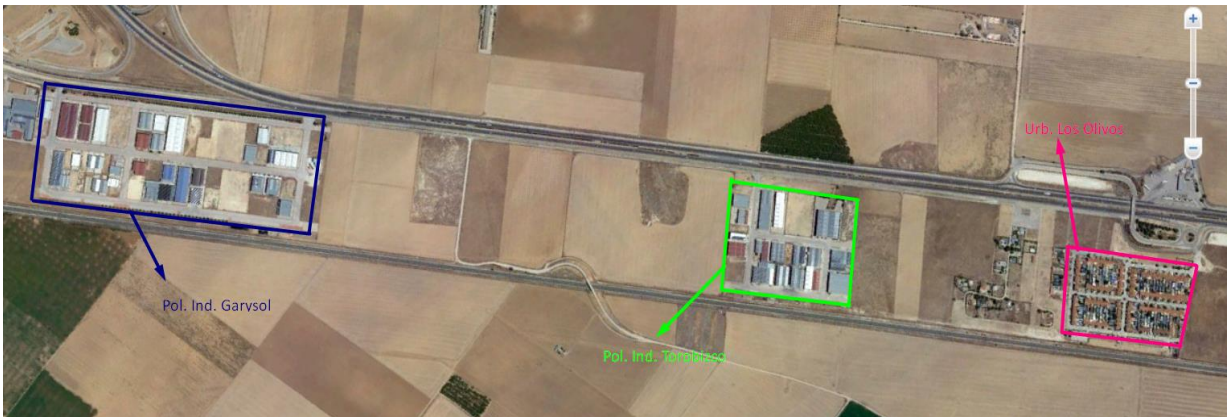
Ilustración 3: Vista aérea, de izquierda a derecha, Pol. Ind. Garysol, Pol. Ind. Torobizco, Urb. Las Casitas
