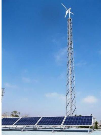
*Ilustración 4. Aerogenerador y placas fotovoltaicas situadas en el techo del LabDER.*
