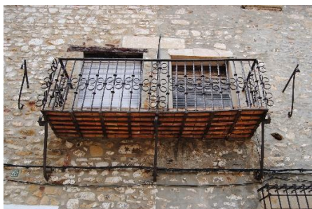
Figura 4.87 - Exemple de reixa de balcó metàl·lica a Puertomingalvo. 2018
