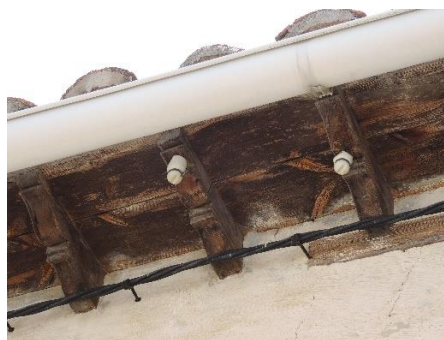
Figura 4.90 - Ràfec de fusta a Puertomingalvo.
