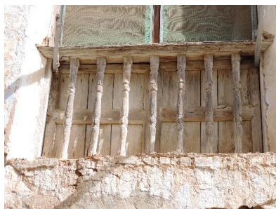
Figura 4.88 - Exemple de reixa de balcó de fusta a les Useres. 2018
