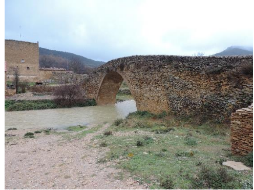
Figura 4.50 - Pont de pedra en sec, Vilafranca.
