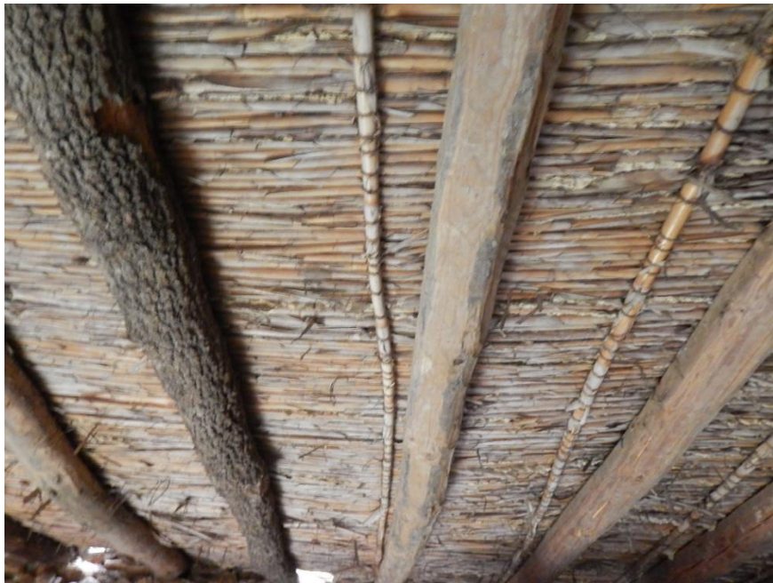
Figura 4.27 - Detall d'una teulada confeccionada amb canya mestra al mas la Granella, Ludiente. 2016
