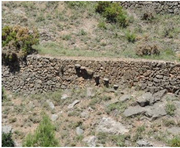
Figura 4.56 - Escalles de carreu a un mur de pedra.
