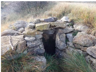
Figura 4.28 - Pou amb cobertura de pedra en sec. 2015
