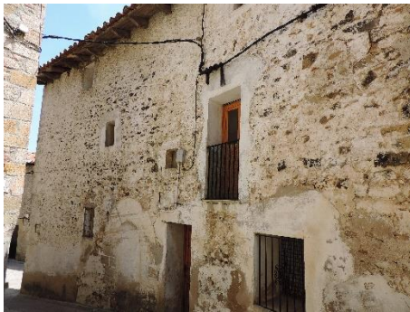
Figura 4.91 - Revestiment tradicional a Puertomingalvo. 2018
