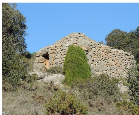
Figura 4.61 - Exemple d'una construcció de pedra en sec.
