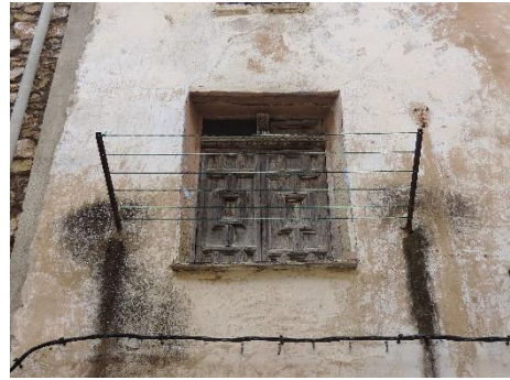
Figura 4.84 - Exemple de finestra cega a les Use-res. 2018
