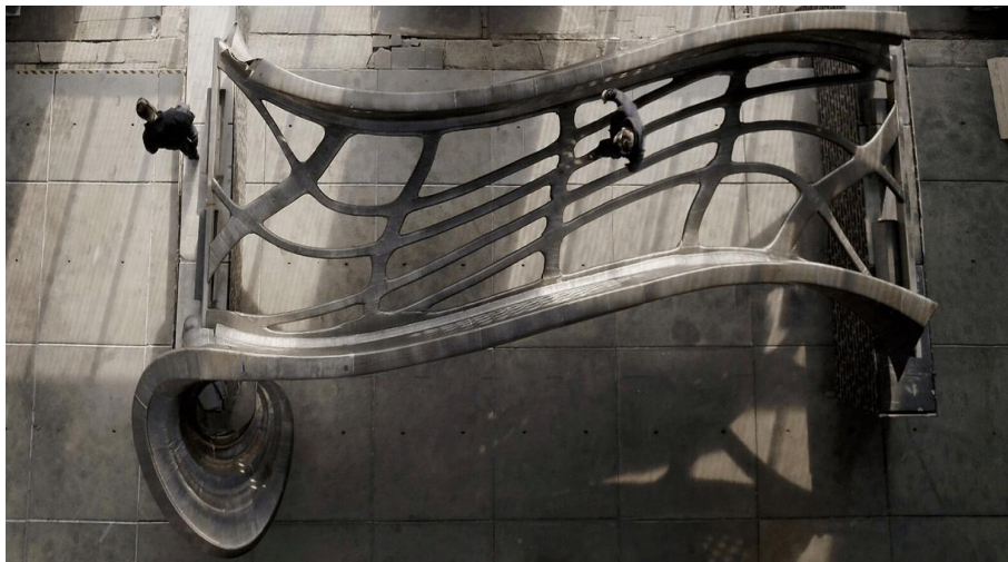
Figura 8. Puente de acero impreso en 3d por MX3D en el centro de Ámsterdam. Fuente: MX3D.
