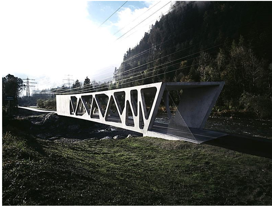
Figura 1. Puente Alfenz. 2017. Fuente: Arquitectura Blanca.
