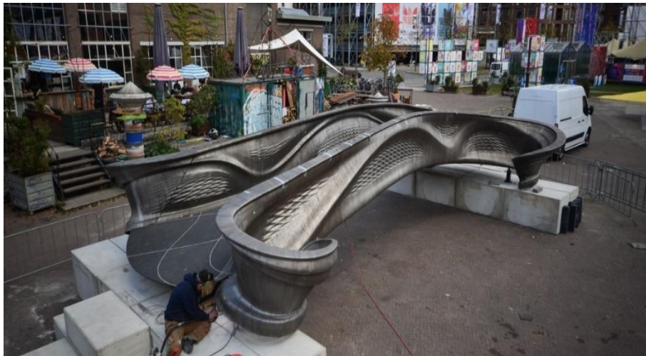
Figura 9. Puente de acero impreso en 3d por MX3D en el centro de Ámsterdam. Fuente: MX3D.
