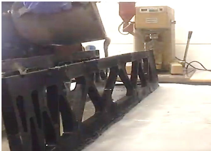
Figura 76. Hormigonado Cubierta. 1º Día de hormigonado. Fuente: Autor.
