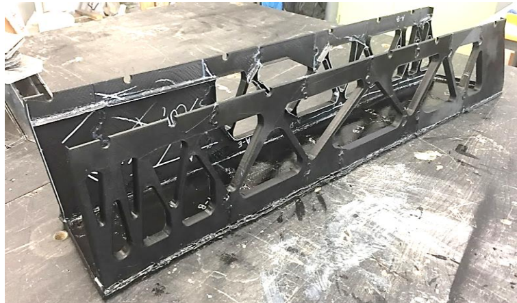
Figura 73. Cubierta y Alzados montados y listos para hormigonar. Montaje parcial de la estructura para mejor facilidad en el hormigonado. Fuente: Autor.
