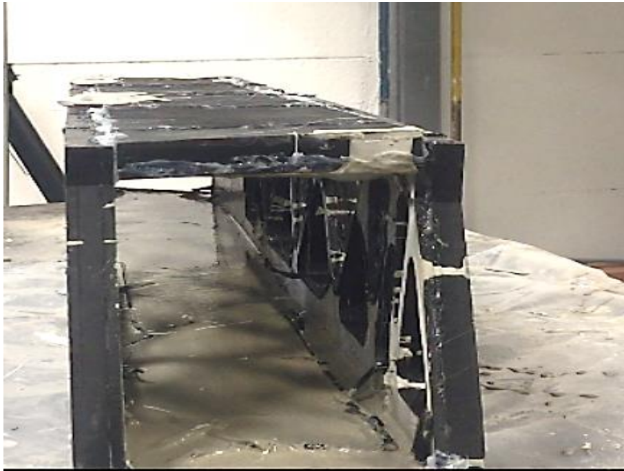
Figura 95. Hormigonado de cubierta con microhormigón-UHPC. Fuente: Autor.
