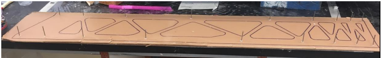
Figura 85. Plantilla para ejecución de armadura de fibra de carbono, CFRP, en Alzado B. Fuente: Autor.
