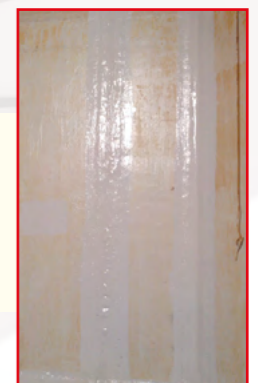
Embebido de las barras con MAXEPOX® CARBOFIX .
