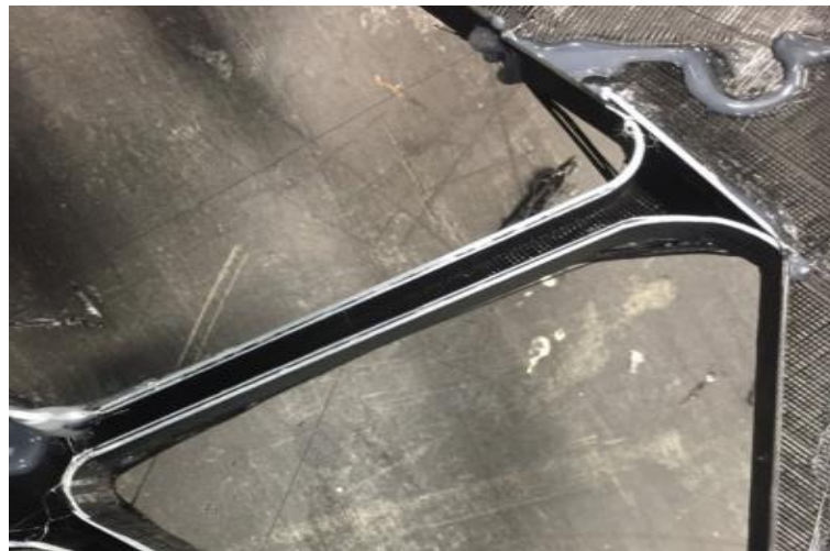
Figura 74. Detalle de sellado de las barras para garantizar estanqueidad cuando se vierta el UHPC. Fuente: Autor.
