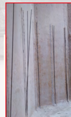
Preparación y replanteo del refuerzo con DRIZORO® CARBOROD .
