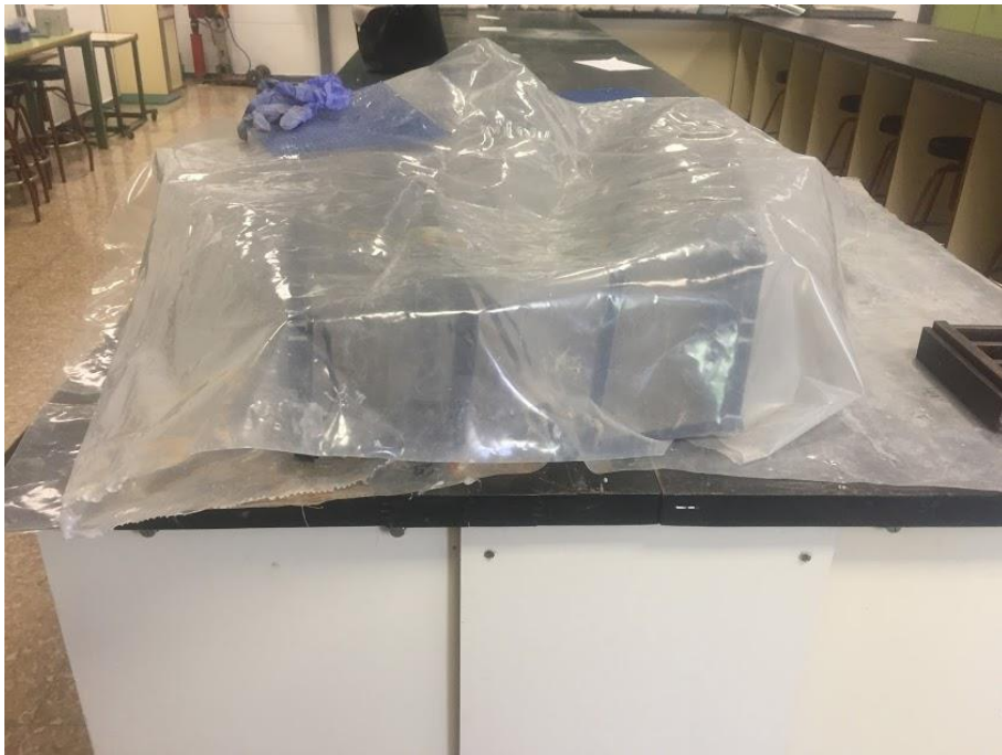
Figura 92. Fase de curado del microhormigón vertido en forjado inferior+Alzados hormigonados en fase anterior. Fuente: Autor.
