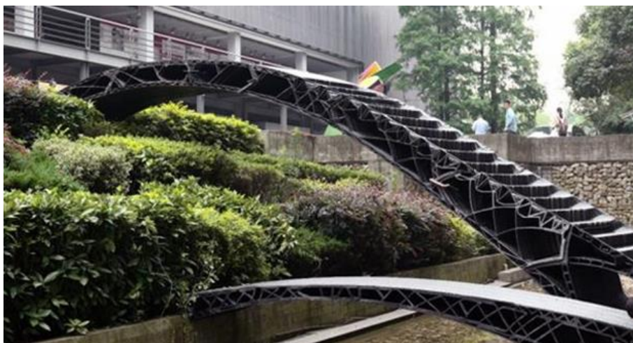
Figura 7. Puente impreso en 3d por el proyecto “Shanghái futuro digital” de la Universidad de Shanghái. Fuente: 3dnatives.
