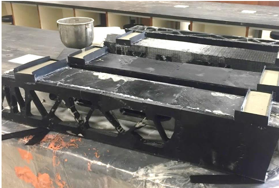
Figura 119. Hormigonado de apoyos inferiores. Fuente: Autor.
