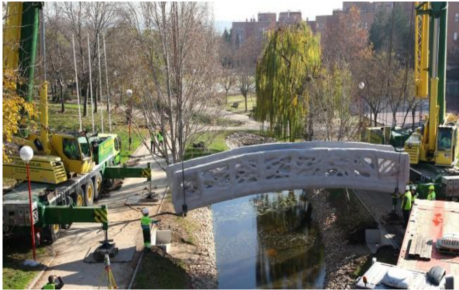
Figura 6. Construcción puente Acciona impreso en 3d – Alcobendas (Madrid). Fuente: Imprimalia3d.
