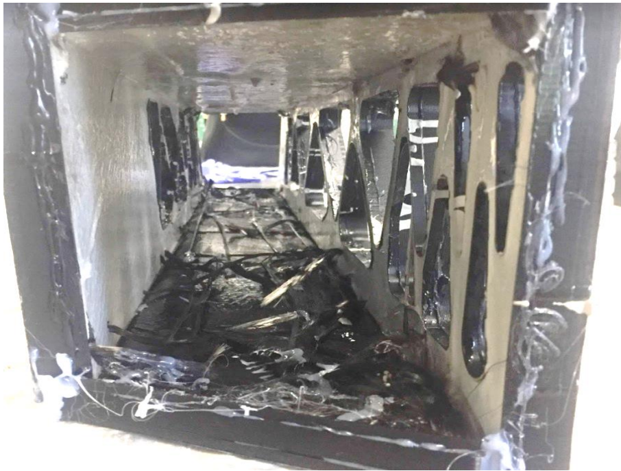
Figura 93. Preparación de cubierta para hormigonado, incluso sellado de juntas con pistola de silicona. Fuente: Autor.
