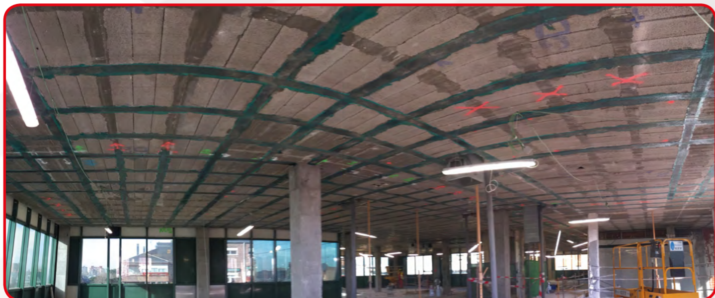
Sustitución de armaduras de acero afectadas por procesos de corrosión.
