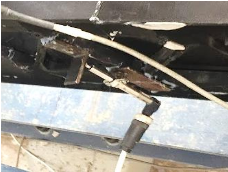
Figura 124. Captador LVDT en barra inclinada. Fuente: Autor.
