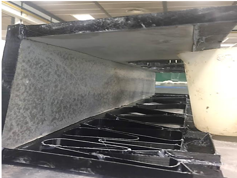
Figura 77. Preparación para hormigonado en Alzado B. Fuente: Autor.
