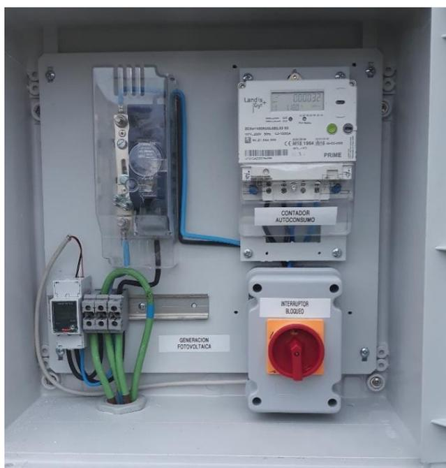
*Imagen 21: Caja de protecciones y medidas con un Smart Meter y un Interruptor de bloqueo.*
