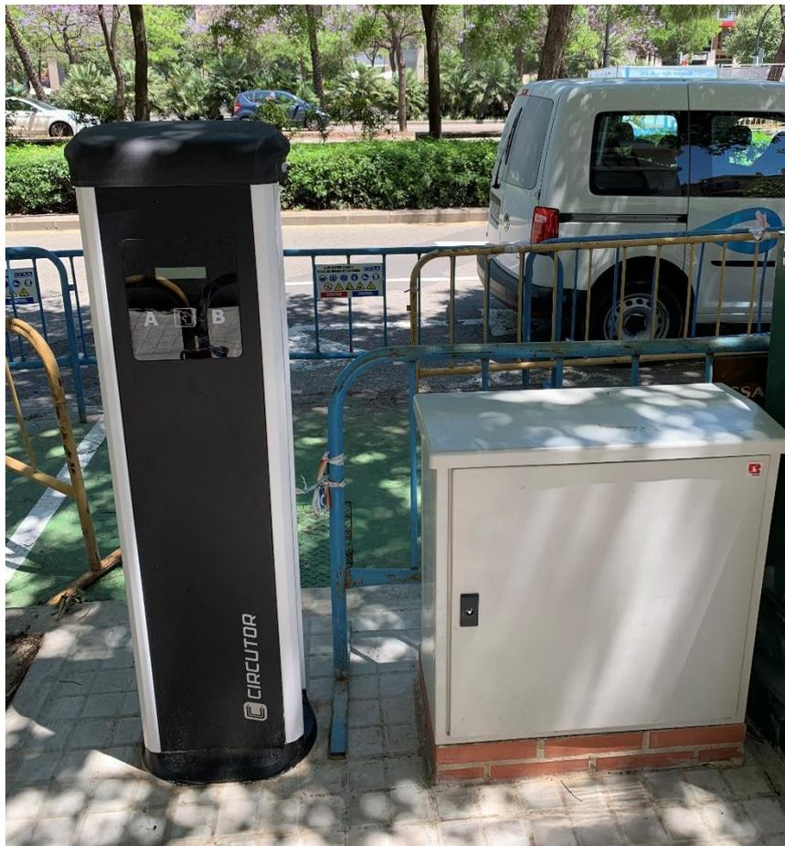
Imagen 31: Cargador Circutor Urban T22 instalado en la Av. De las Cortes Valencianas
