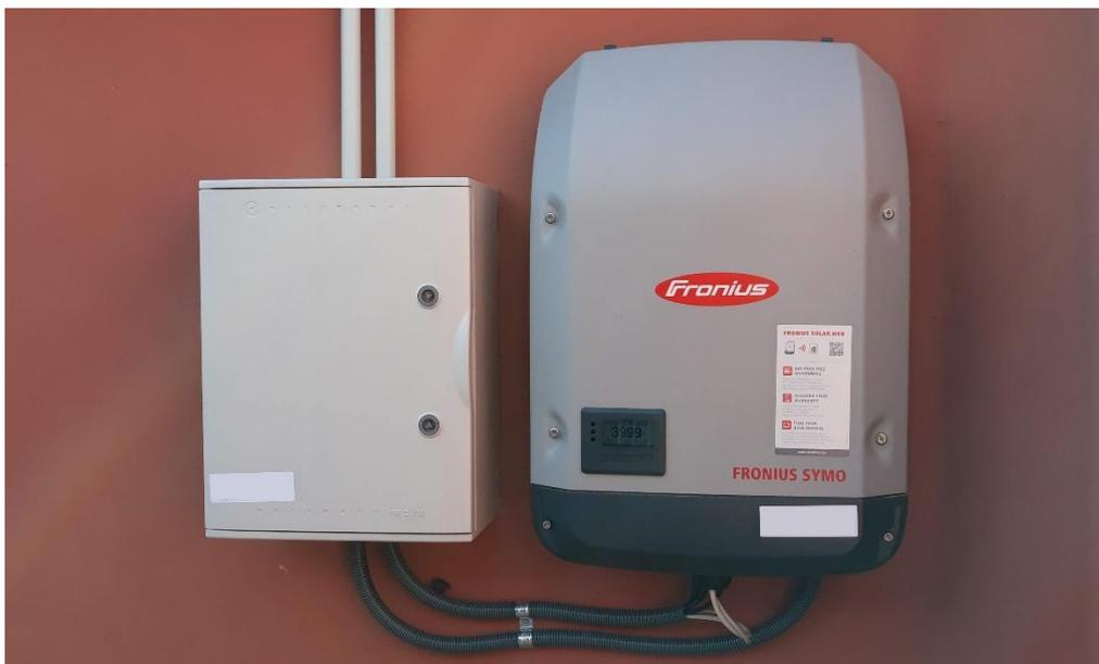
Imagen 22: Inversor Fronius Symo junto a su Caja de Protecciones
