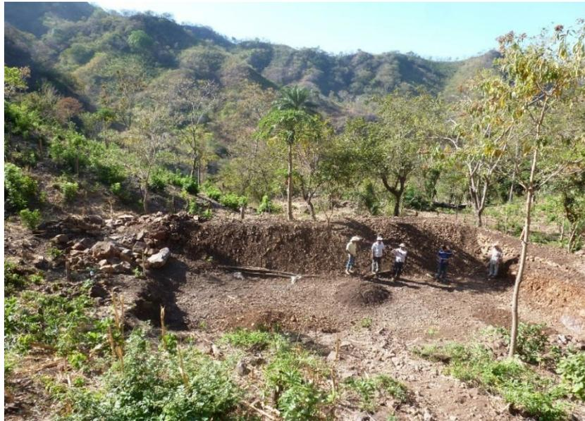
*Ilustración 13: Proceso de construcción de un depósito estacional.*
