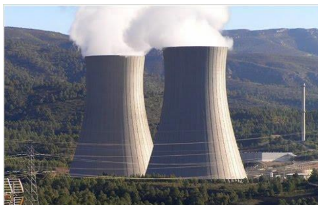
Fig. 14 Ejemplo de Torre con geometría de Hiperboloide de una hoja en las Torres de refrigeración de la central nuclear Cofrentes (Fuente: refineering.wordpress.com , consultada día 25/3/19)
