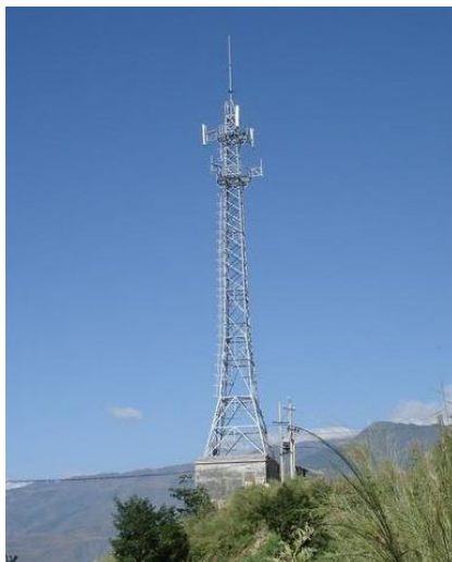
Fig. 10 Pararrayos en Torre de Telecomunicaciones (Fuente: grupomecsa.net, consultada día 25/3/19)
