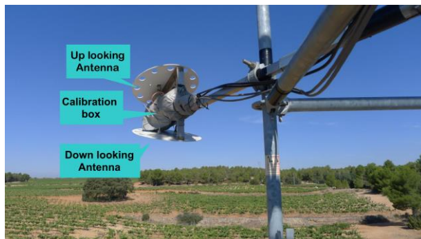
Ilustración 23, Imagen de detalle de la instalación de la antena oceanpal [28]
