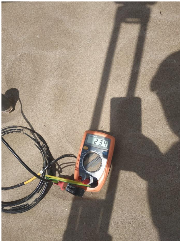
Ilustración 58, Amperímetro mostrando un voltaje de 234V.
