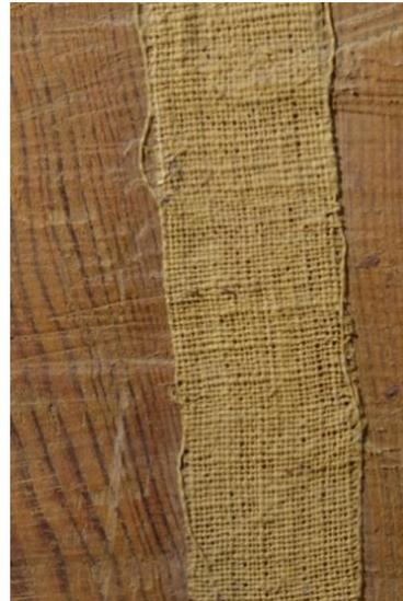
Fig.12. Detalle de refuerzo de las juntas mediante bandas de tela
