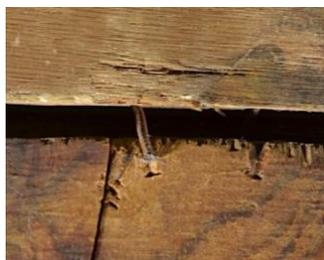
Fig.37. Fotografía de detalle de sujeción de marco a la obra y los daños provocados
