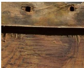
Fig.36. Fotografía de detalle de orificios debido al anclaje y mancha generada por la oxidación de los tornillos
