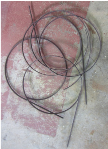
Fig. 34. Obra propia, proceso de construcción de la esfera. Primer paso, doblado a circunferencias.
