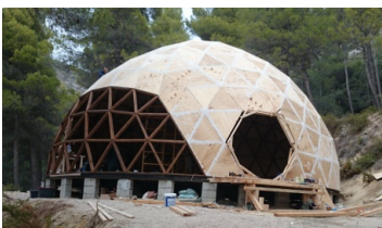
Fig. 22. Domo geodésico en construcción, Alicante.
