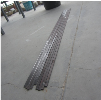
Fig. 33. Obra propia, proceso de construcción de la esfera. Estado de las pletinas antes de comenzar.
