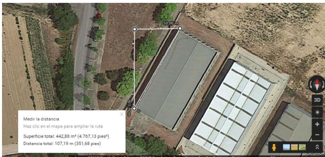
FIGURA 9. Vista de la nave industrial desde Google Earth.
