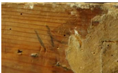
Figura 20. Fotografía de detalles de ataques de insectos xilófagos.
