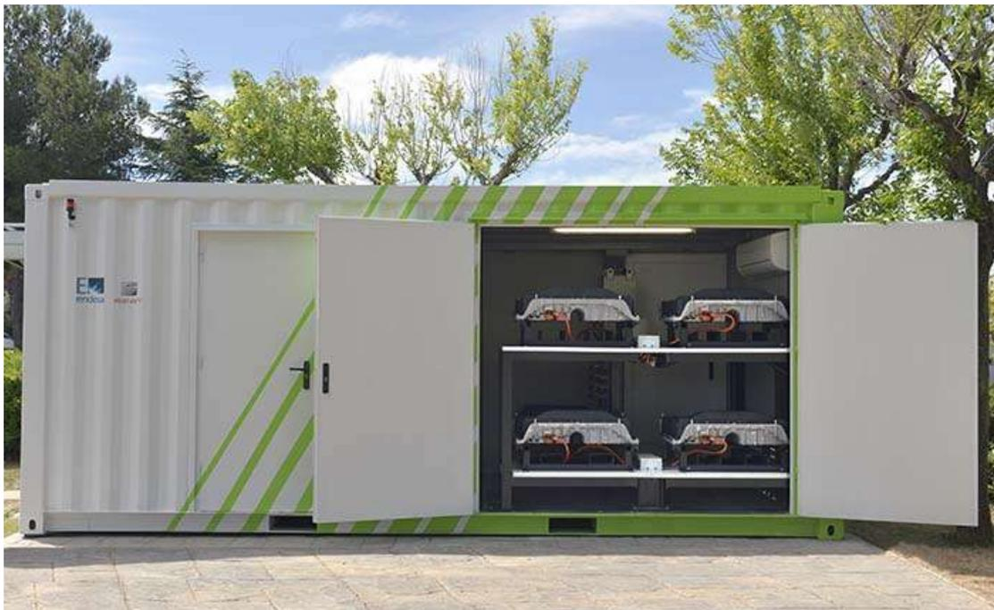
Figura2. Proyecto Sunbatt, baterías reutilizadas acopladas a micro red. Fuente: Diario renovables.com.
