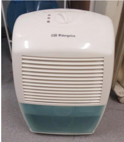
Fig. 28 Deshumidificador instalado en la sala de la biblioteca de la UPV donde se almacenan las obras.
