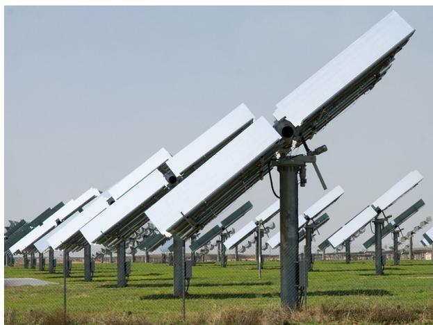
Figura 6.1: Solar tracker de la planta de producción fotovoltaica de Sevilla. Referencia [7].
