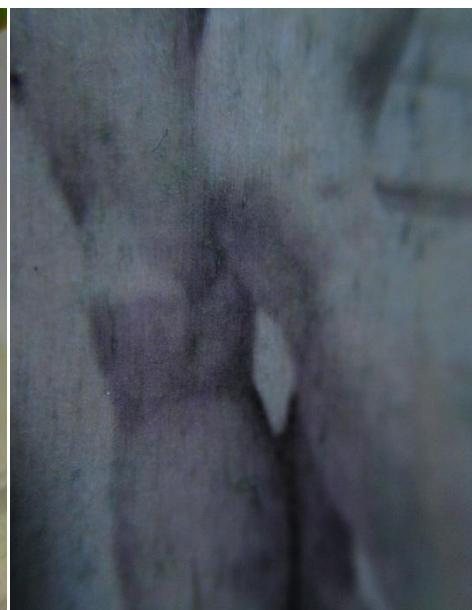
Figura 17. Estado de la zona al retirar la gota.
