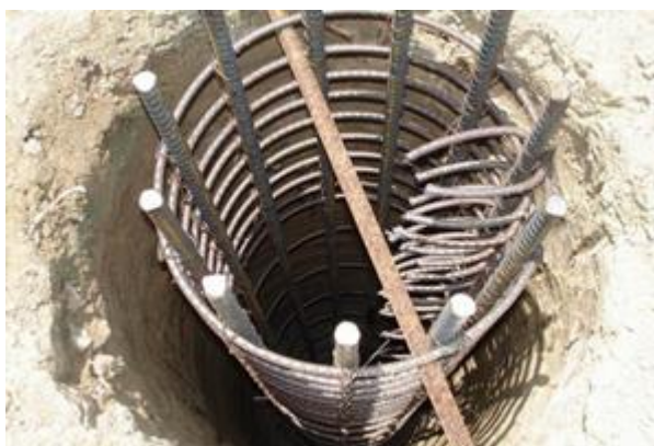
Figura 7. 9. Caisson de cimentación. ( https://weinsteinconstruction.com/caissons/ ).
