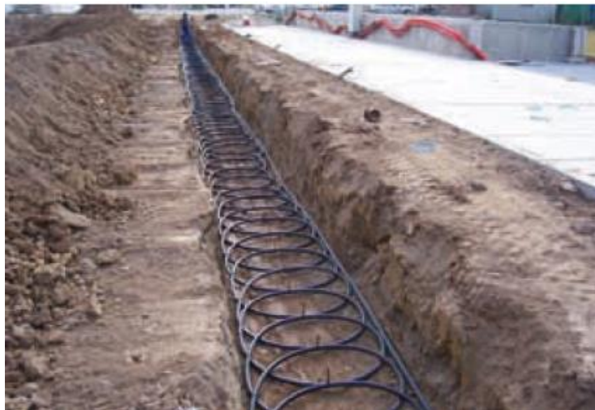
Figura 4. 11. Intercambiador horizontal en espiral. Guía Técnica para el Diseño de Bombas de Calor Geotérmica del IDAE.
