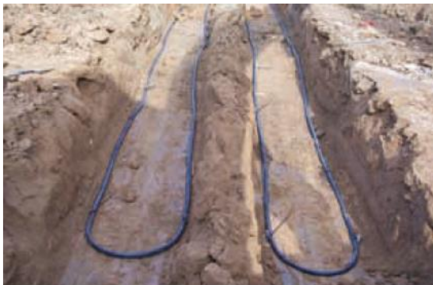
Figura 4. 10. Intercambiador horizontal en trinchera. Guía Técnica para el Diseño de Bombas de Calor Geotérmica del IDAE.
