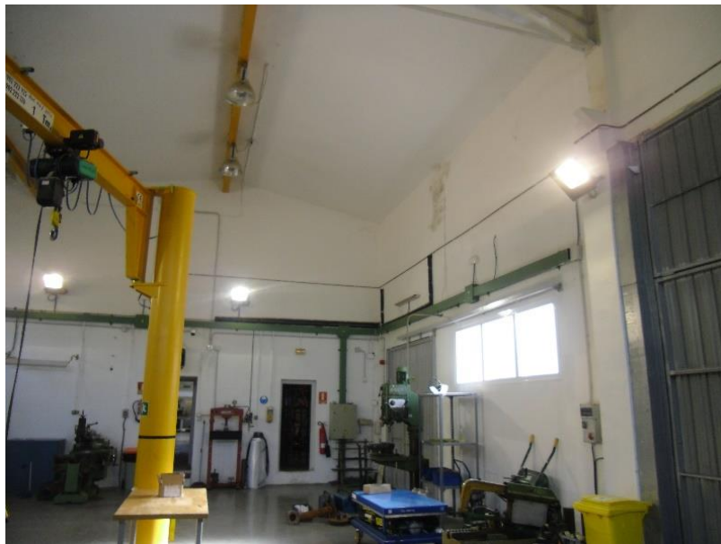
Fotografía 3. Vista general 2 Taller mecanizados.
