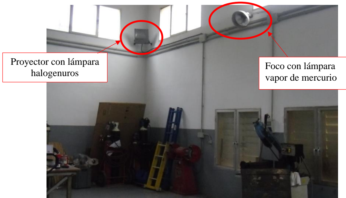
Fotografía 11. Vista parcial de detalle N° 6. Taller de calderería.
