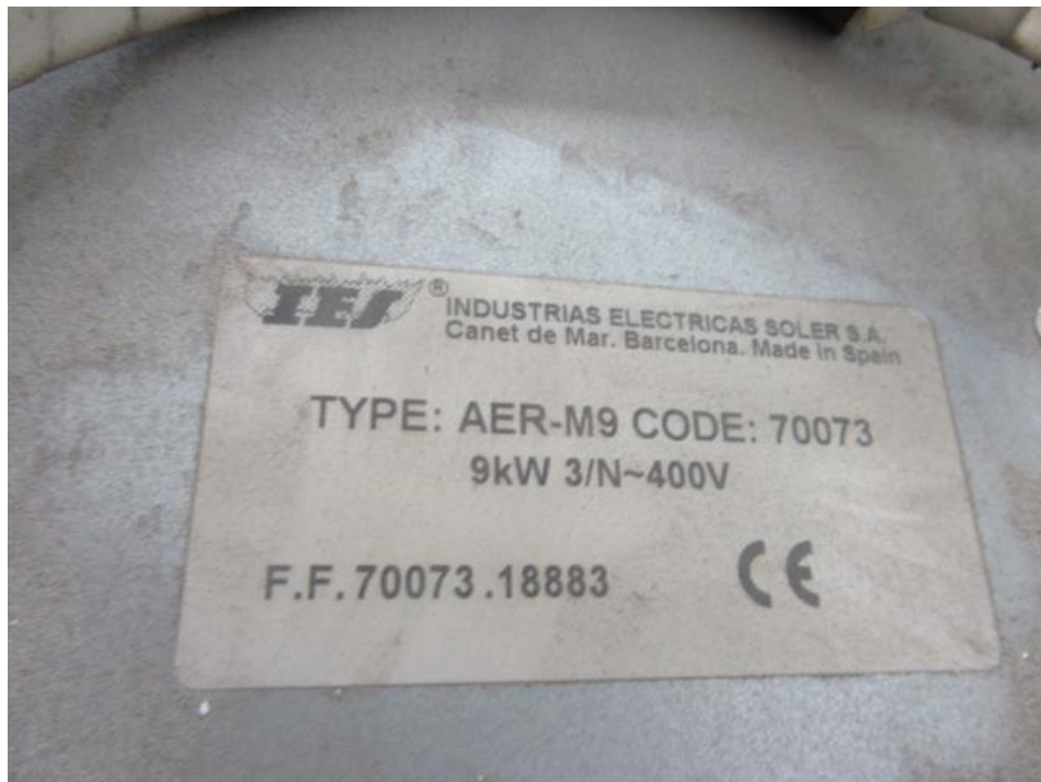
Fotografía 33. Calefactor trifásico taller mecanizado y calderería. Placa características.
