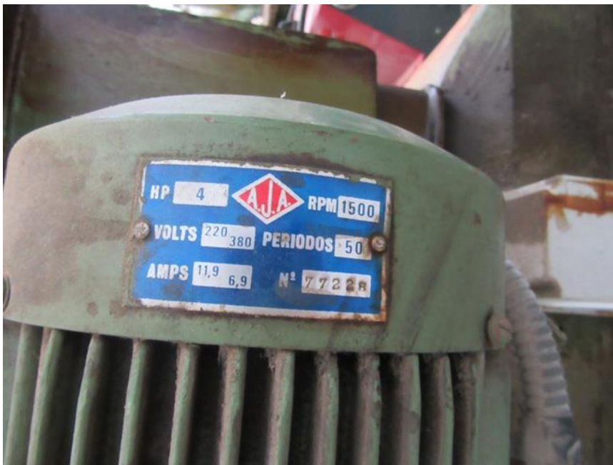
Fotografía 19. Fotografía limadora y placa de características eléctricas.
