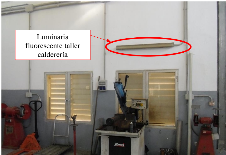
Fotografía 10. Vista parcial de detalle N° 5. Taller de calderería.
