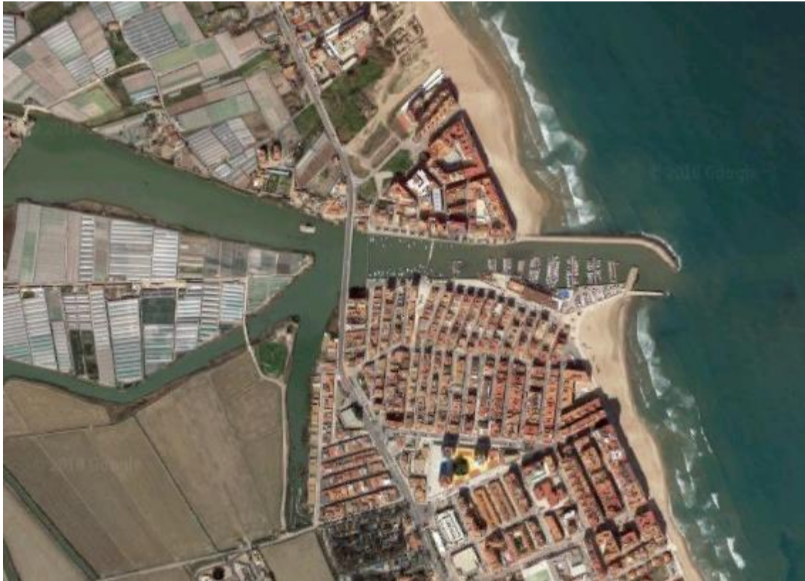
Ilustración 2. Vista aérea del puerto de El Perelló.
