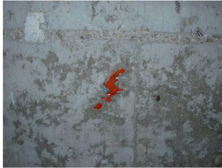
2- Fondo del encofrado sucio al hormigonar
