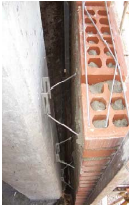
Foto de la construcción del sistema
