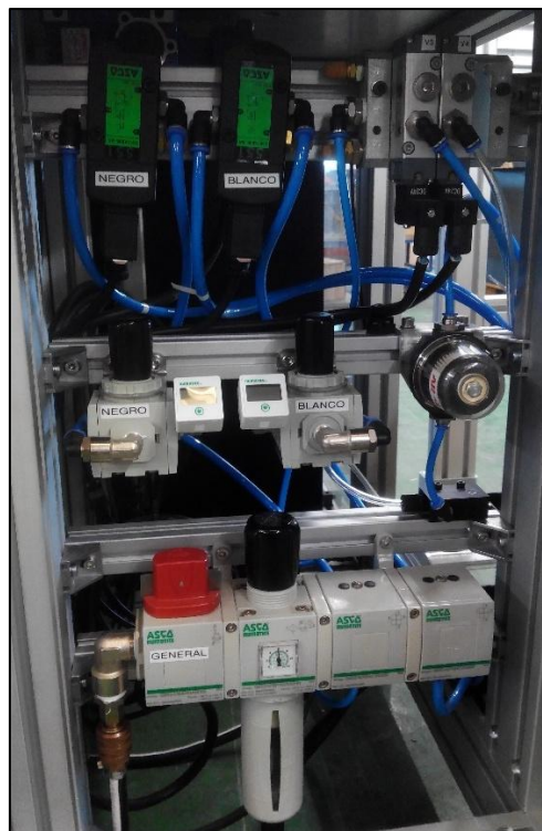
Fig. 21: Detalle preparación y control
