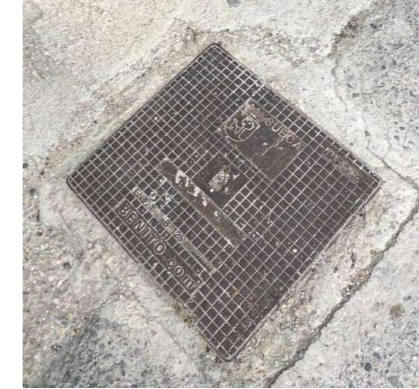
Ilustración 33. Red de alumbrado público. Fuente: Elaboración propia.
