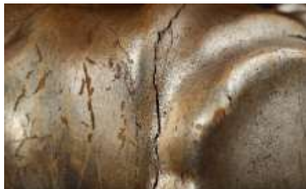
Imagen 54 Una de las grietas que recorren la peana.
