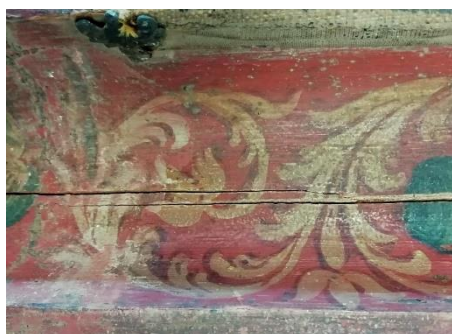
Figura 46. Detalle de la astilla de la grieta estructural.
