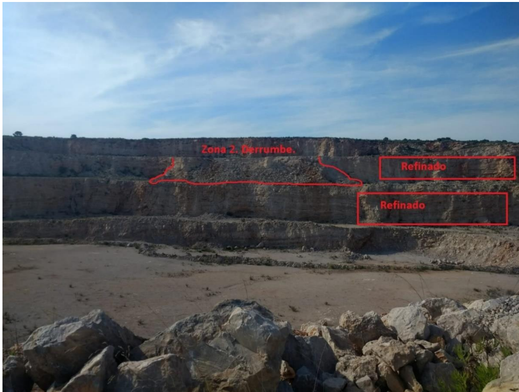
Figura 24. Taludes que sufrirán un refinado para conseguir una mejor estabilidad del talud.
