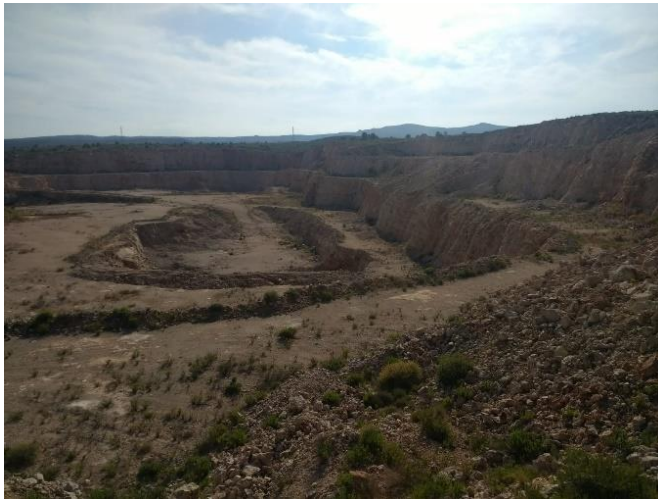
Figura 17. Hueco 1, situado al Este de la cantera. cantera.
