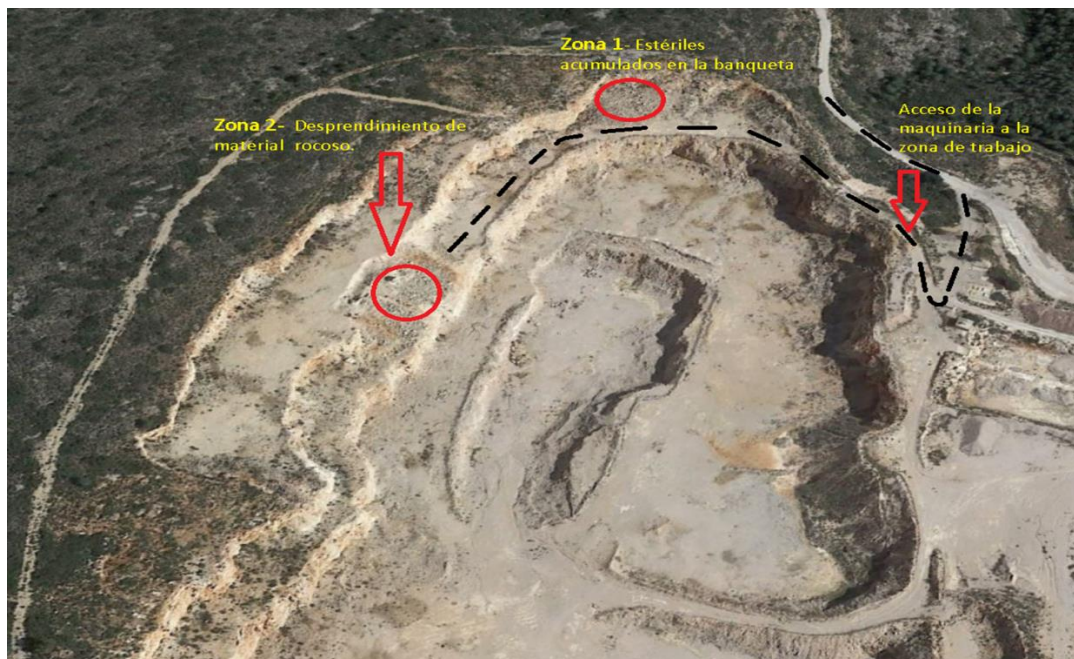
Figura 22. Zona 1 y 2 de desmonte.
