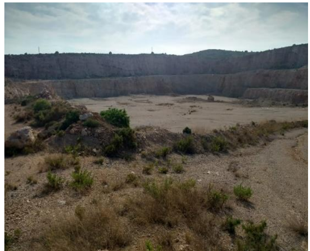
Figura 10. Taludes situados al Noroeste.
