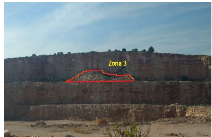
Figura 16. Zona 3 de desmonte.
