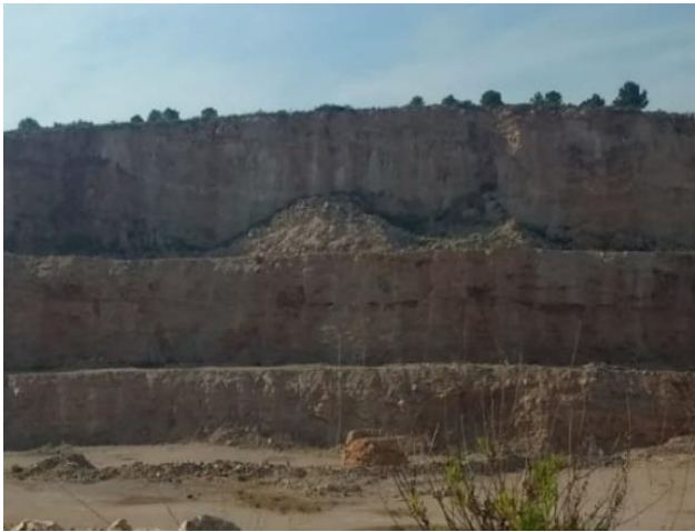
Figura 11. Taludes situados al Norte
