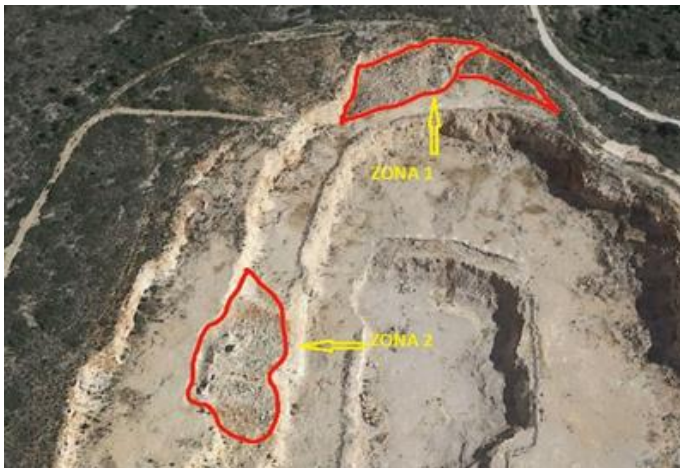
Figura 15. Zonas 1 y 2 de desmonte.
