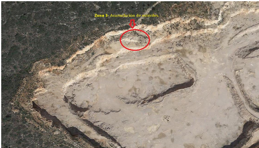
Figura 23. Zona 3 de desmonte.
