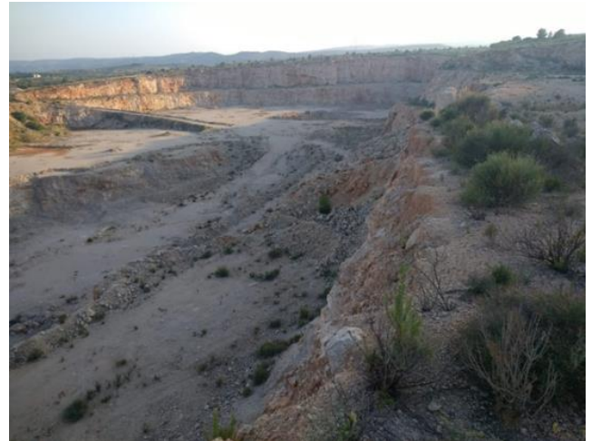
Figura 12. Taludes situados al noroeste.
