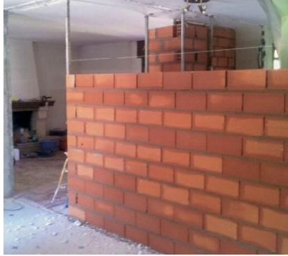
Figura 9: Tabiques. Fuente: www.arrevol.com
