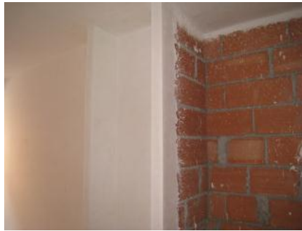
Figura 10: Guarnecido y enlucido de yeso. Fuente: www.preoc.es
