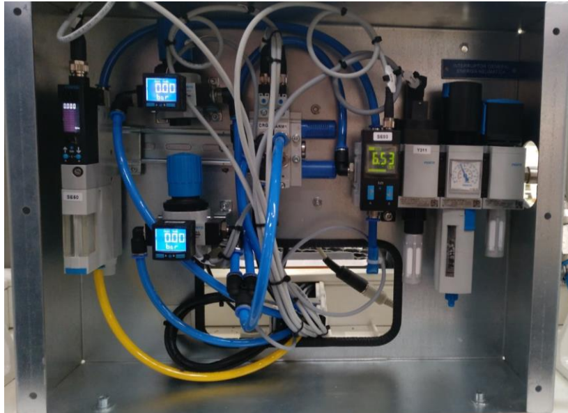
Fig. 39: Instalación cajón neumático FS13
