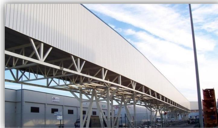
Figura 19. Conveyer de Ford que conecta con múltiples proveedores. Fuente: Itercon<sup>25</sup>
