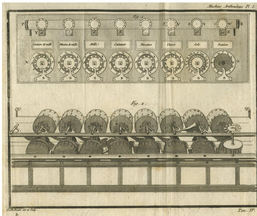
**Figura 4.6:** Vista superior de la pascalina junto a la cadena de engranajes que componen el mecanismo.
