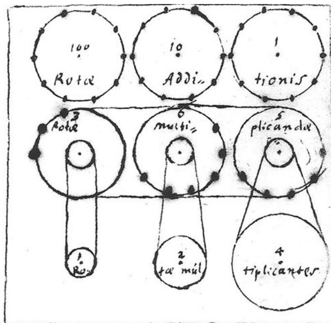
Figura 4.18: Boceto del primer mecanismo inventado por Leibniz para la multiplicación y división.
