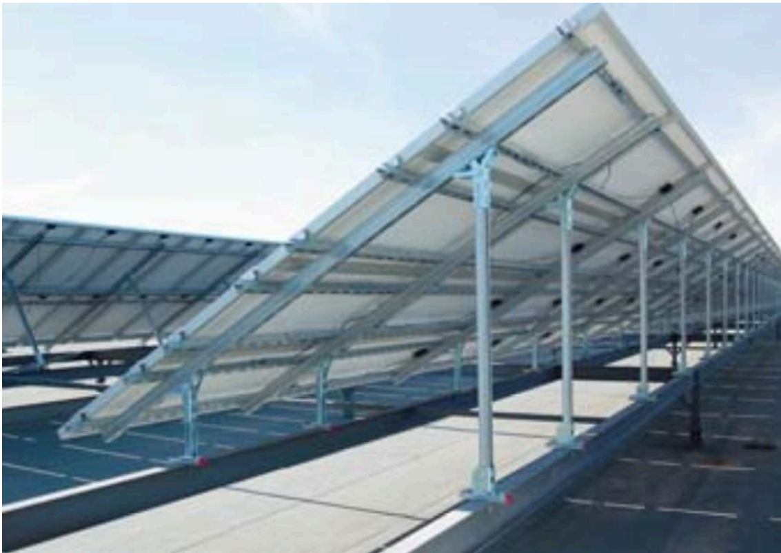
Ilustración 52. Estructura metálica en carril.
