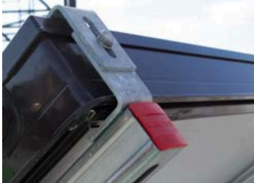
Ilustración 53. Fijación del colector a la placa.
