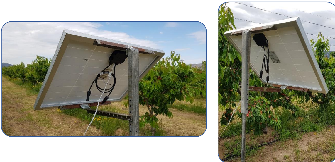
Figura 5. Módulo solar y el soporte diseñado instalados en campo.
