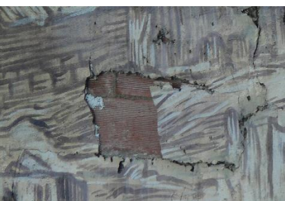
Fig. 22. Detalle 1 de los pequeños espejos fijados sobre la superficie del mural (muro oeste).
