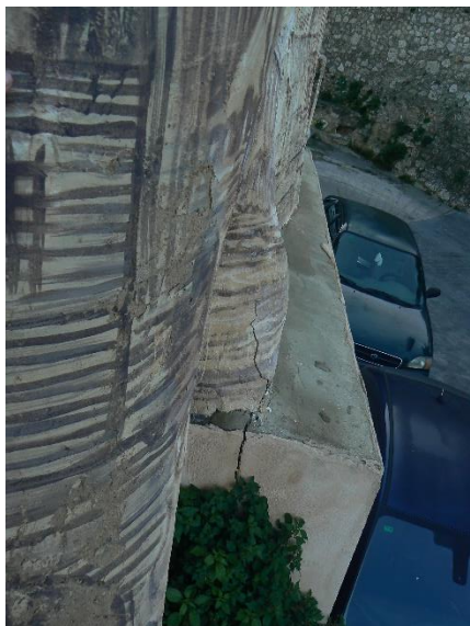
Fig. 28. Vista en perspectiva de la parcela con vegetación contigua a la fachada norte de la pintura mural.
