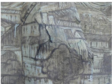
Fig. 34. Detalle de la pérdida en la zona de la viga de madera (muro norte).
