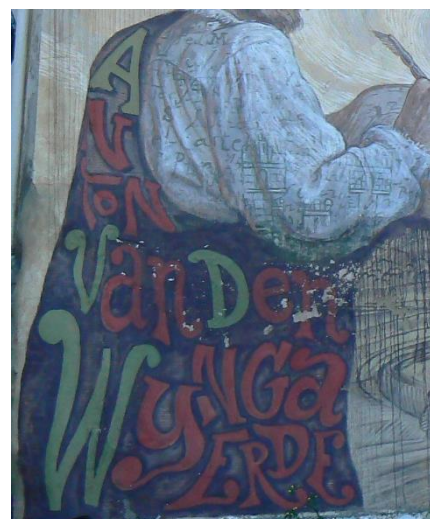
Fig. 26. Detalle del acabado de la obra en el año 2014 (muro norte).
