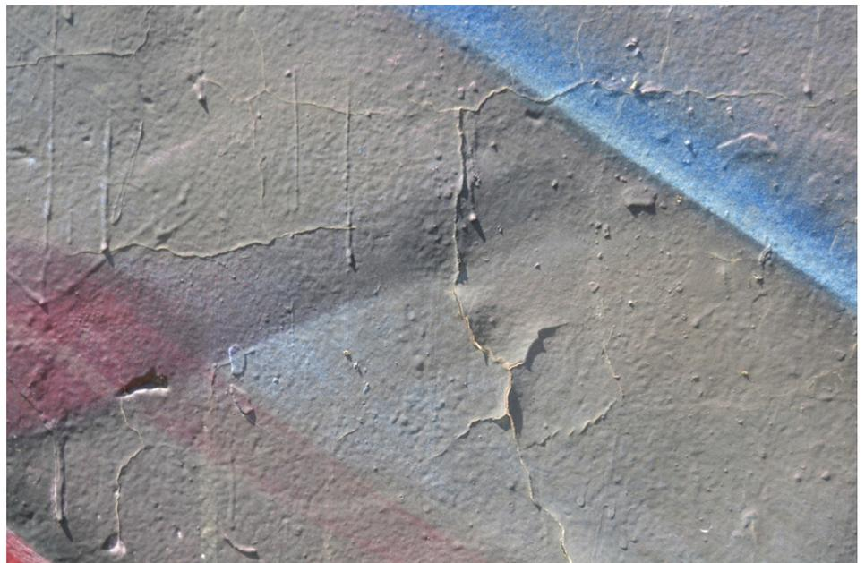
Figura 42. Detalle grieta con separación de partes.
