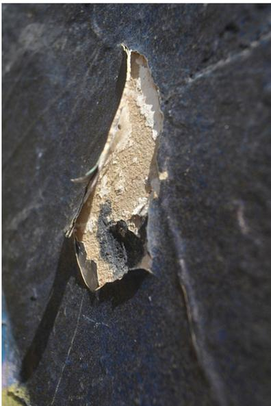
Figura 34. Detalle faltante de película pictórica, preparación y muro.
