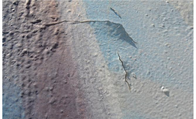
Figura 41. Detalle grieta con separación de partes.
