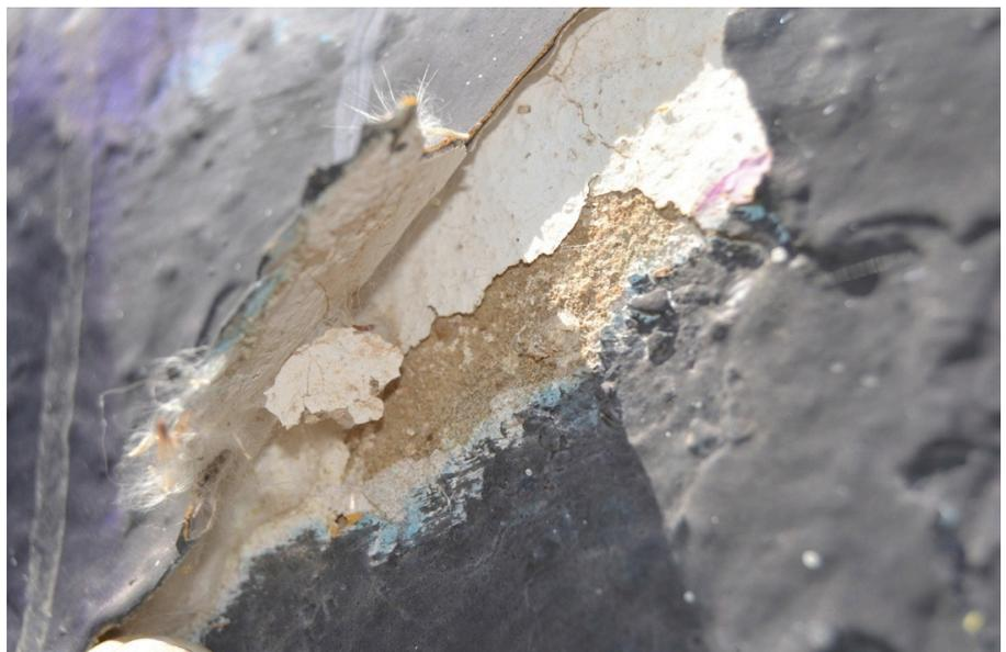
Figura 35. Detalle faltante de película pictórica, preparación y muro.
