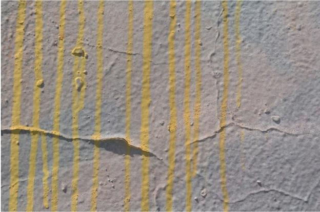
Figura 40. Detalle grieta con separación de partes.
