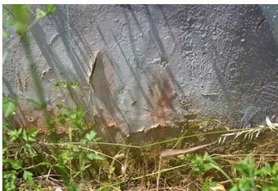
Figura 22. Humedad recibida por contacto con el terreno.
