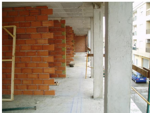
Ilustración 9: Tabiquería. Fuente: enriquealario.com/ladrillo-o-pladur
