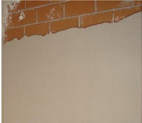
Ilustración 8 : Guarnecido y enlucido de Yeso. Fuente: leccionesdesignprofdiezdelcorral.blogspot.com
