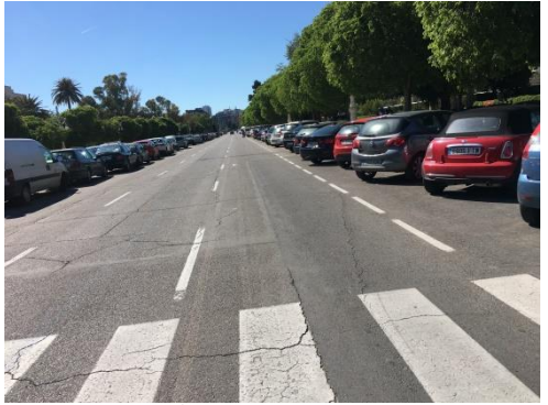
ILUSTRACIÓN 24. PASEO DE LA ALAMEDA 5
