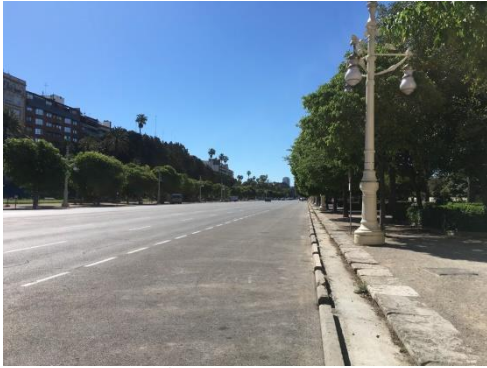
ILUSTRACIÓN 19. PASEO DE LA ALAMEDA 2
