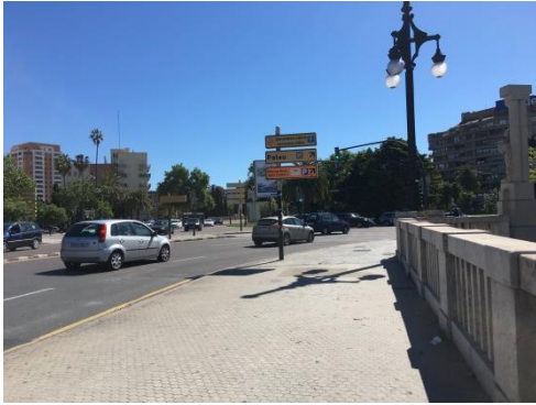
ILUSTRACIÓN 39. PUENTE DE ARAGÓN 2
