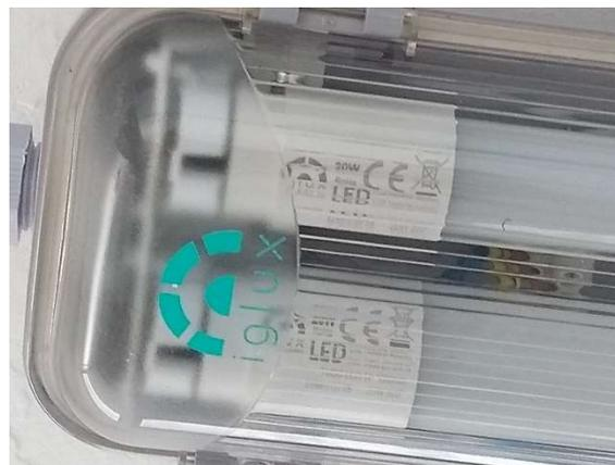
*Ilustración 45. Luminaria LED 2x20W*
