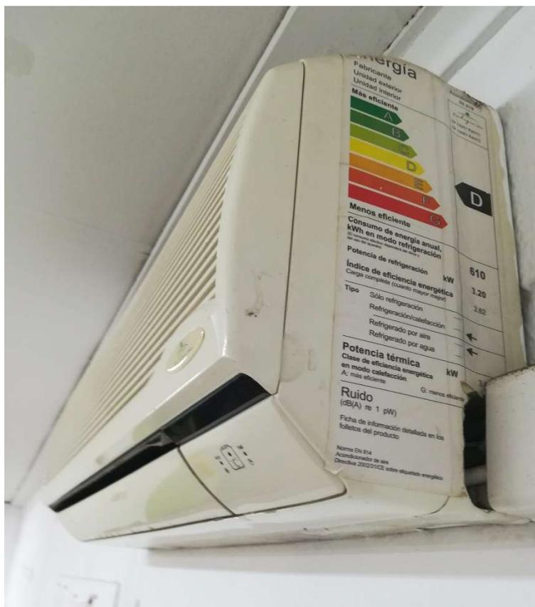
Ilustración 55. Unidad interior de los equipos de climatización del edificio
