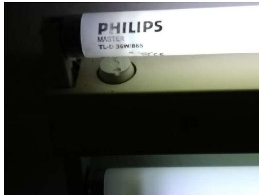
*Ilustración 44. Luminaria fluorescente 2x36W*
