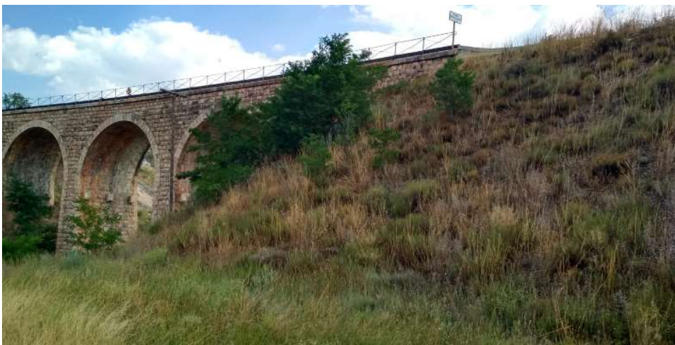
Fotografía 2 Vegetación del talud desde la margen izquierda
