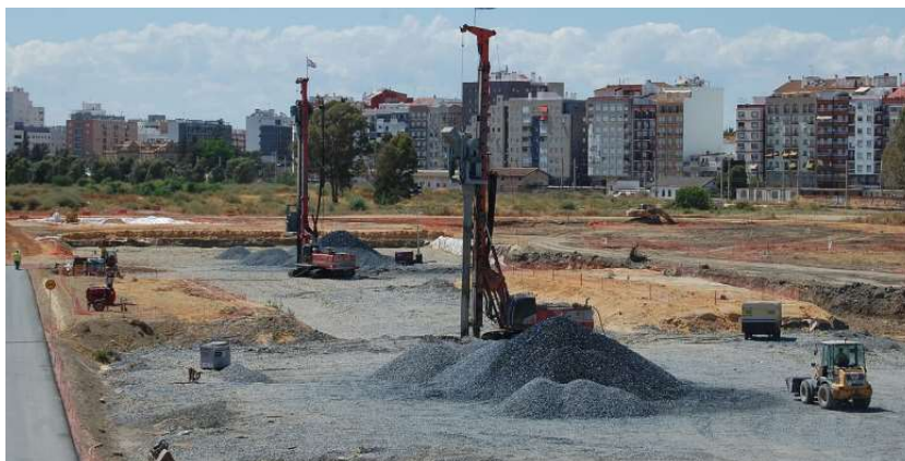
Fotografía 7 Acopios de grava en mejora de terreno mediante columnas de grava (Menard)
