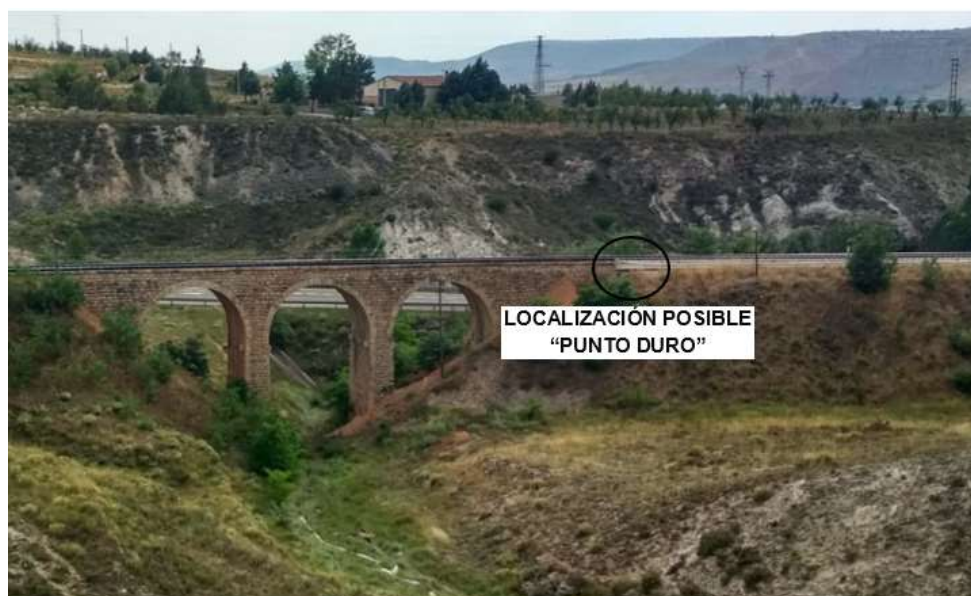
Fotografía 6 Localización de posible "punto duro" debido a la diferencia de rigideces
