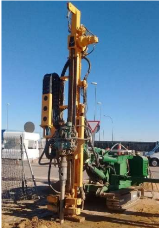
Fotografía 9 Equipo empleado para la ejecución de micropilotes
