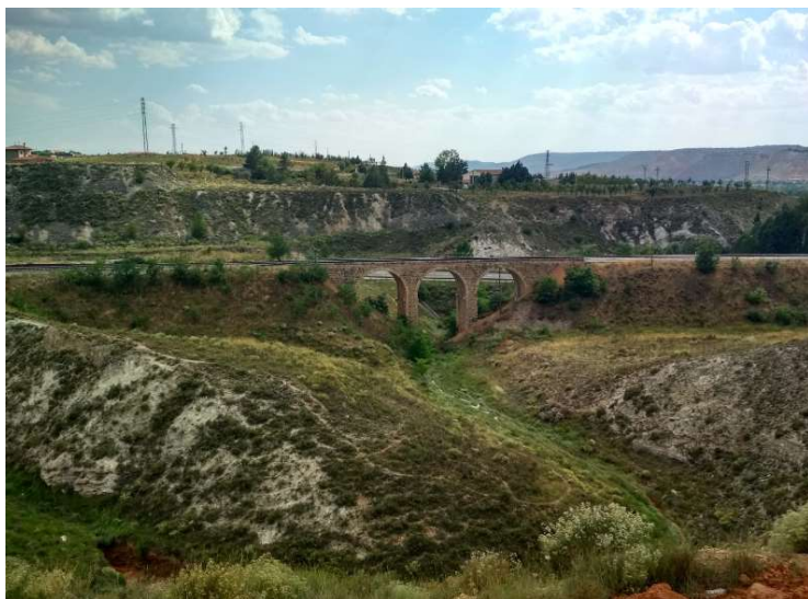
Fotografía 4 Vista del relieve de la zona así como del viaducto de la Rambla de Caladín y del terraplén objeto de estudio
